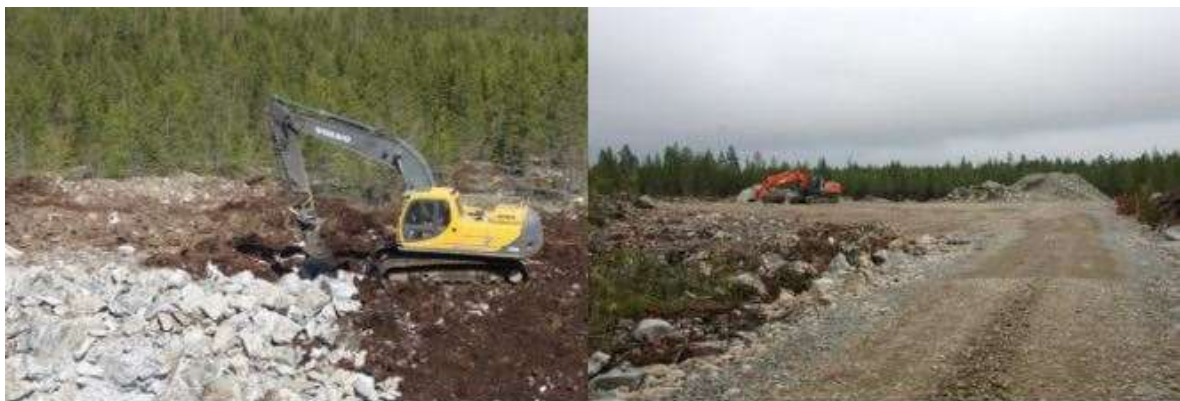
Kuva 5.10 Tuulivoimapuiston rakentaminen alkaa huoltoteiden ja pystytysalueiden rakentamisella (FCG).
