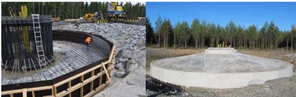
Kuva 5.12 Tuulivoimalan perustusten rakentamista (Leila Väyrynen, FCG).
