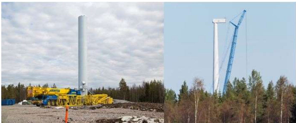
Kuva 5.13 Tuulivoimalan kokoamista (FCG).
