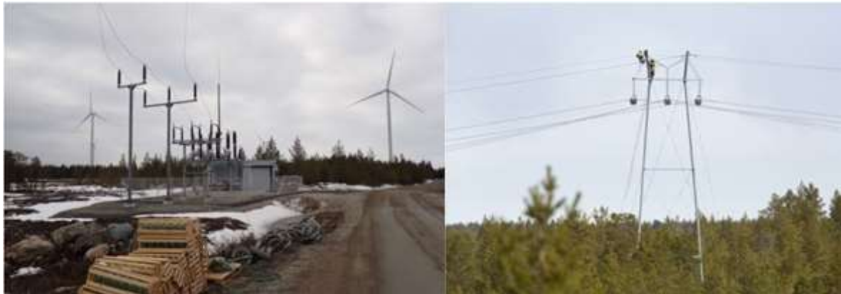
Kuva 5.15 Sähköaseman ja voimajohdon rakentamista (Ville Suorsa, FCG).
