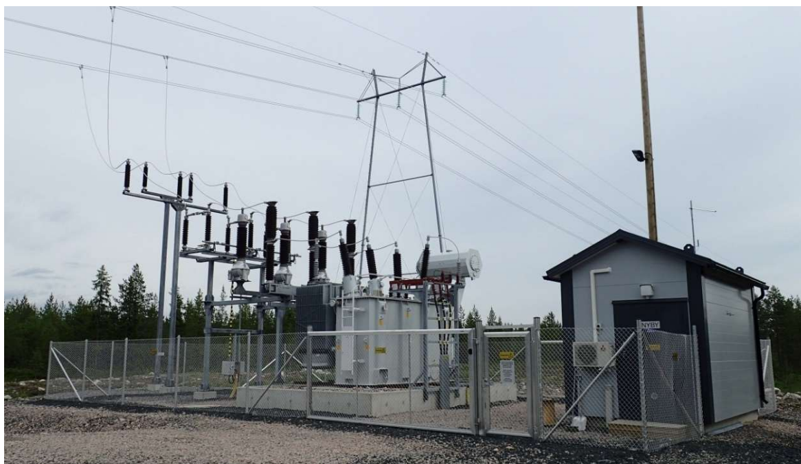
Kuva 5.8 Esimerkki tuulivoimapuiston sähköasemasta (FCG).
