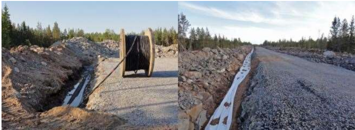
Kuva 5.11 Maakaapelit upotetaan huoltoteiden yhteyteen (FCG).
