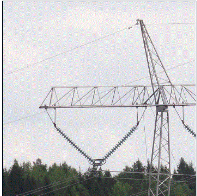
Kuva 6.5. Voimajohtopylvään eristimiä, joissa koronapurkauksia voi esiintyä.
