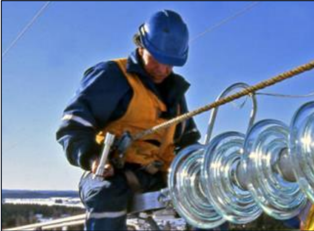
Kuva 6.5. Voimajohtopylvään eristimiä, joissa koronapurkauksia voi esiintyä.
