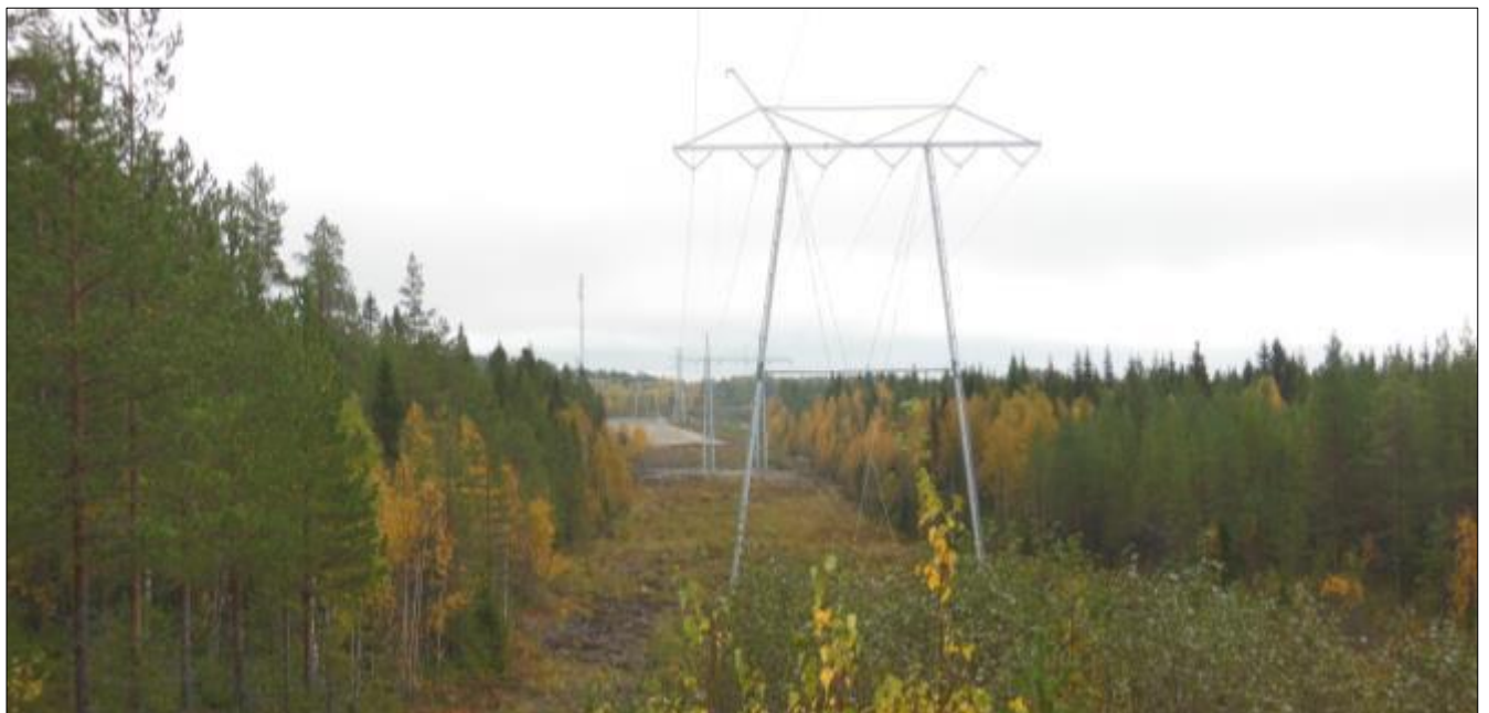
Kuva 4.15. 110 kilovoltin kahden virtapiirin harustettu portaalipylvä, jossa virtapiirit ovat samassa tasossa.
