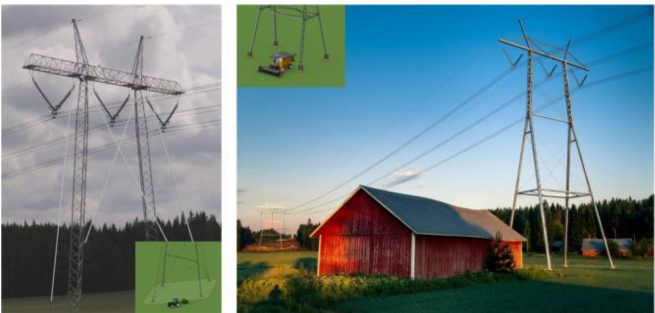
Kuva 4.13. 400 kilovoltin pylvästyyppejä. Vasemmalla harustettu portaalipylväs (peruspylvästyyppi) ja oikealla harustamaton peltopylvästyyppi.
