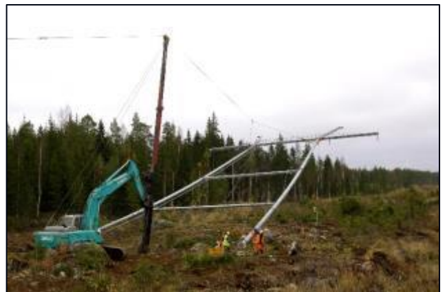
Kuva 3.7. Voimajohtopylvään pystytys.
