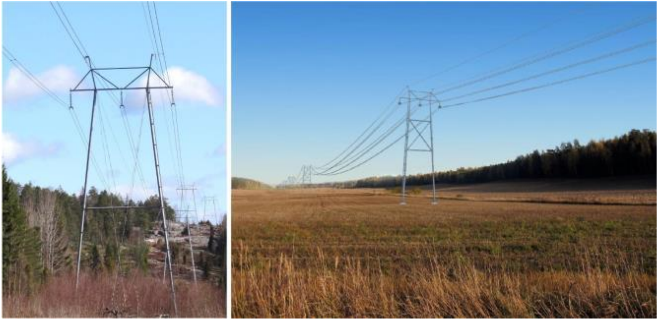
Kuva 4.14. 110 kilovoltin pylvästyyppejä. Vasemmalla harustettu portaalipylvä (peruspylvästyyppi) ja oikealla harustamaton peltopylvästyyppi.
