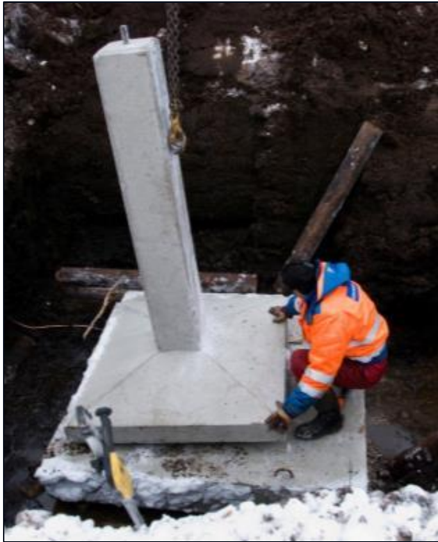
Kuva 3.4. Harustetun pylvään perustuselementin asentaminen.
