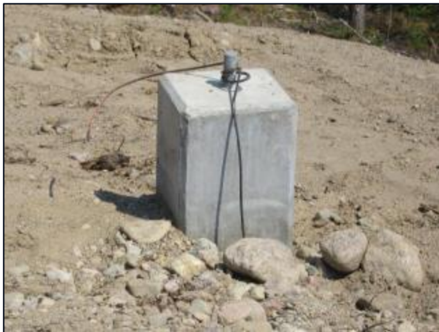
Kuva 3.5. Pylväsjalan perustus ja maadoituselektrodi johdin.
