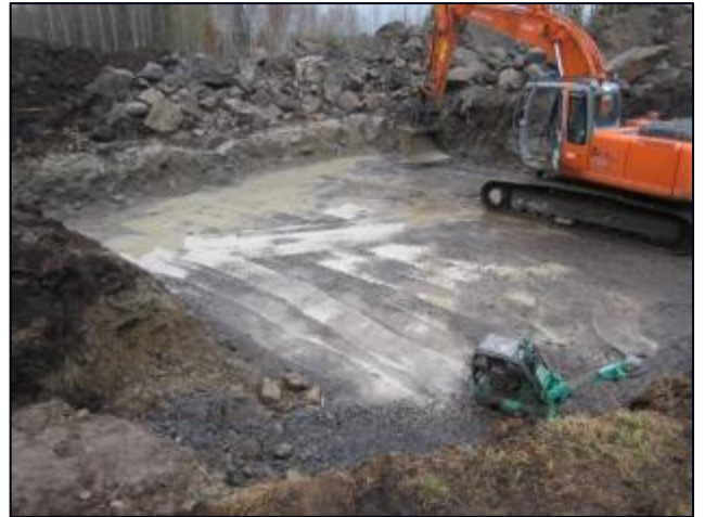
Kuva 3.6. Vapaasti seisovan pylvään perustuksen pohjatöitä
