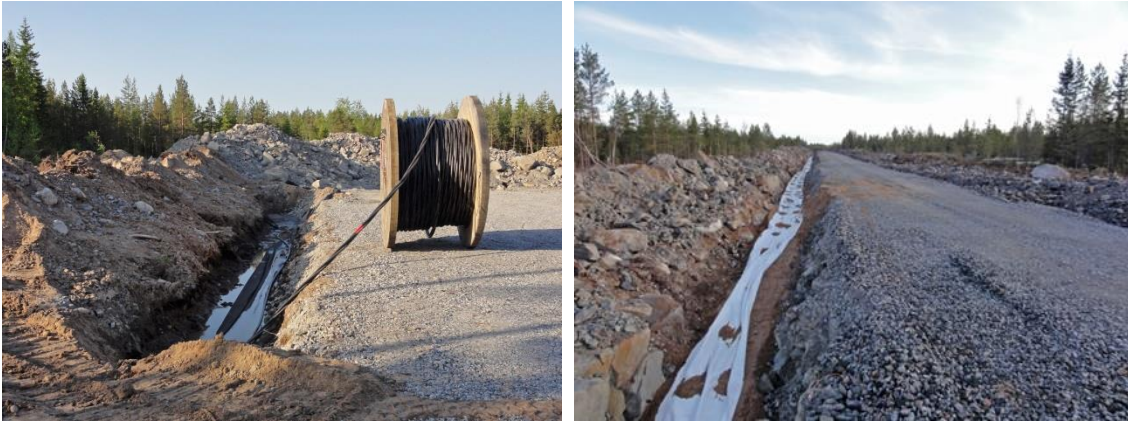
Kuvapari 4-8. Maakaapelit upotetaan huoltoteiden yhteyteen (Kuvat: Ville Suorsa/FCG).
