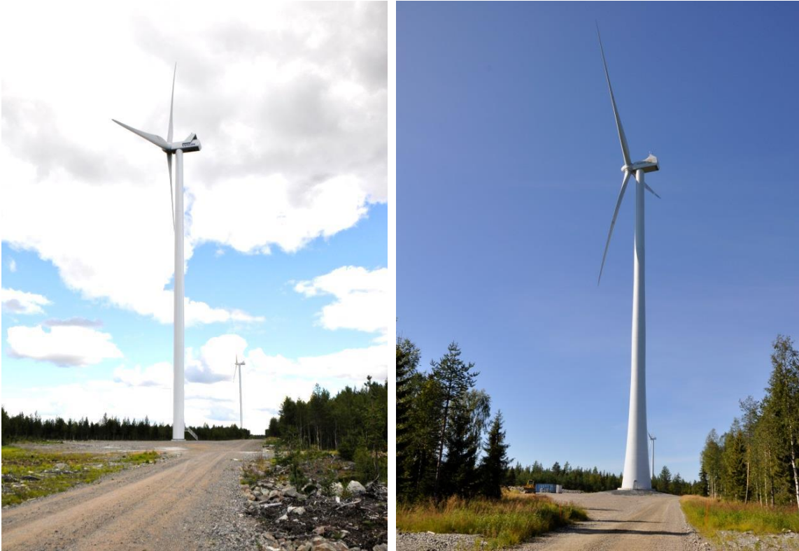
Kuvapari 4-1. Vasemmalla on esimerkki teräslieriötornista ja oikealla hybriditornista (Kuvat: Leila Väyrynen/FCG).
