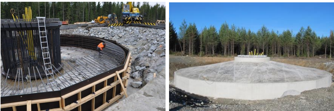
Kuvapari 4-9. Tuulivoimalan perustusten rakentamista. (Kuvat: Leila Väyrynen/FCG)
