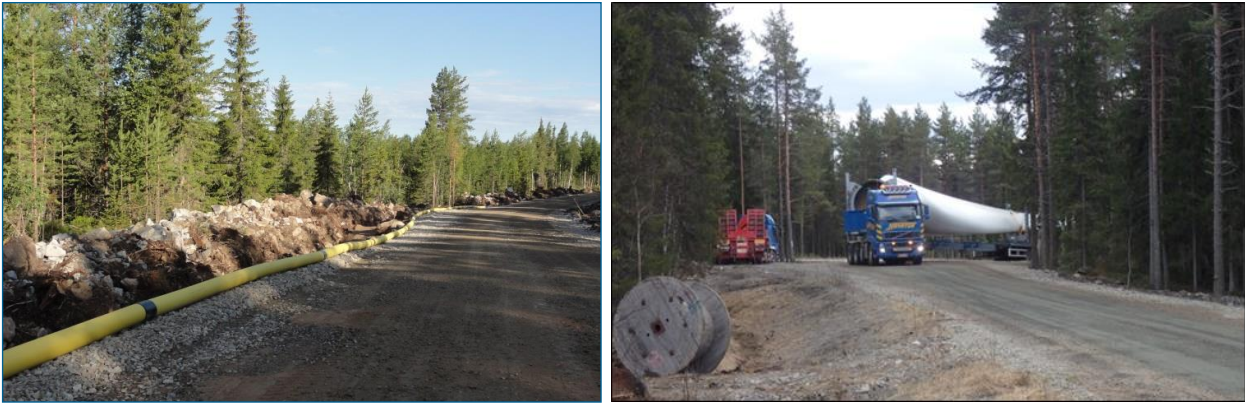
Kuvapari 4-5. Vasemmalla: Esimerkki tuulivoimapuiston rakennus- ja huoltotiestä. Maakaapeli sijoitetaan ojakaivantoon tien reuna-alueelle. Oikealla: Tuulivoimalakomponentteja kuljetetaan erikoiskuljetuksina (Kuvat: Ville Suorsa/FCG).
