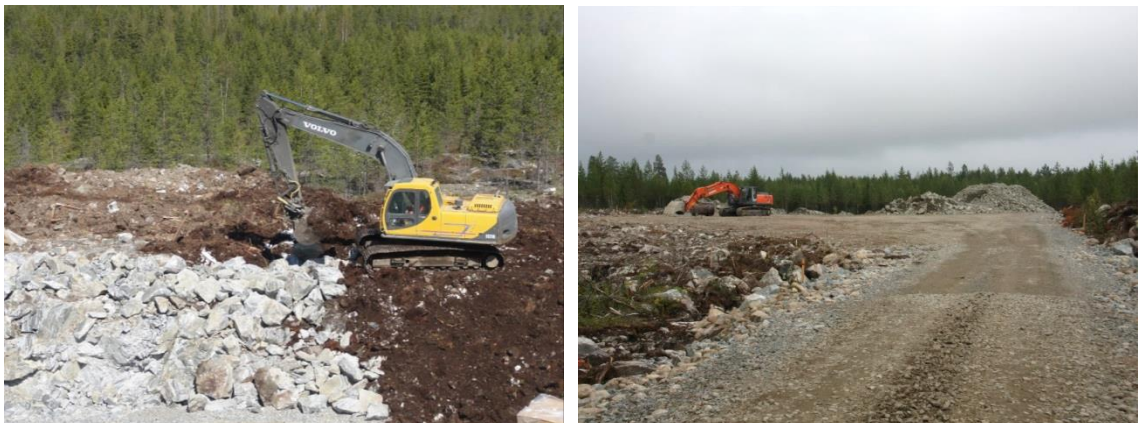
Kuvapari 4-7. Huoltoteiden ja pystytysalueiden rakentamista (Kuvat: Ville Suorsa/FCG).
