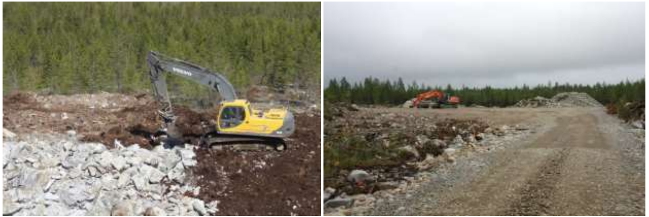
Kuvapari 5.8. Tuulivoimapuiston rakentaminen alkaa huoltoteiden ja pystytysalueiden rakentamisella (kuvat: Ville Suorsa/FCG).
