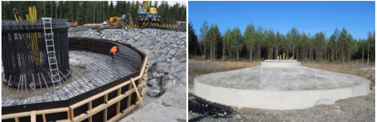
Kuvapari 5.10. Tuulivoimalan perustusten rakentamista. (Kuvat: Leila Väyrynen, FCG)
