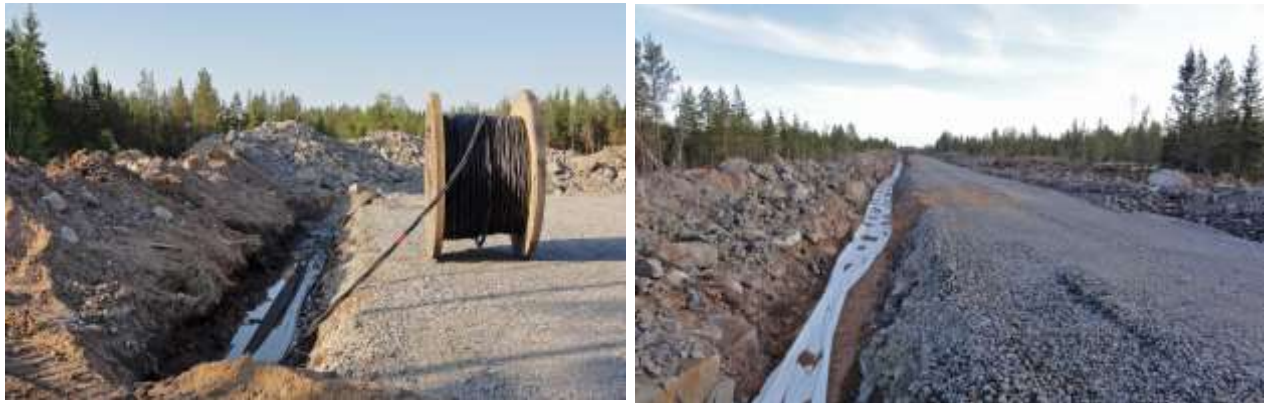
Kuvapari 5.9. Maakaapelit upotetaan huoltoteiden yhteyteen (kuvat: Ville Suorsa/FCG).
