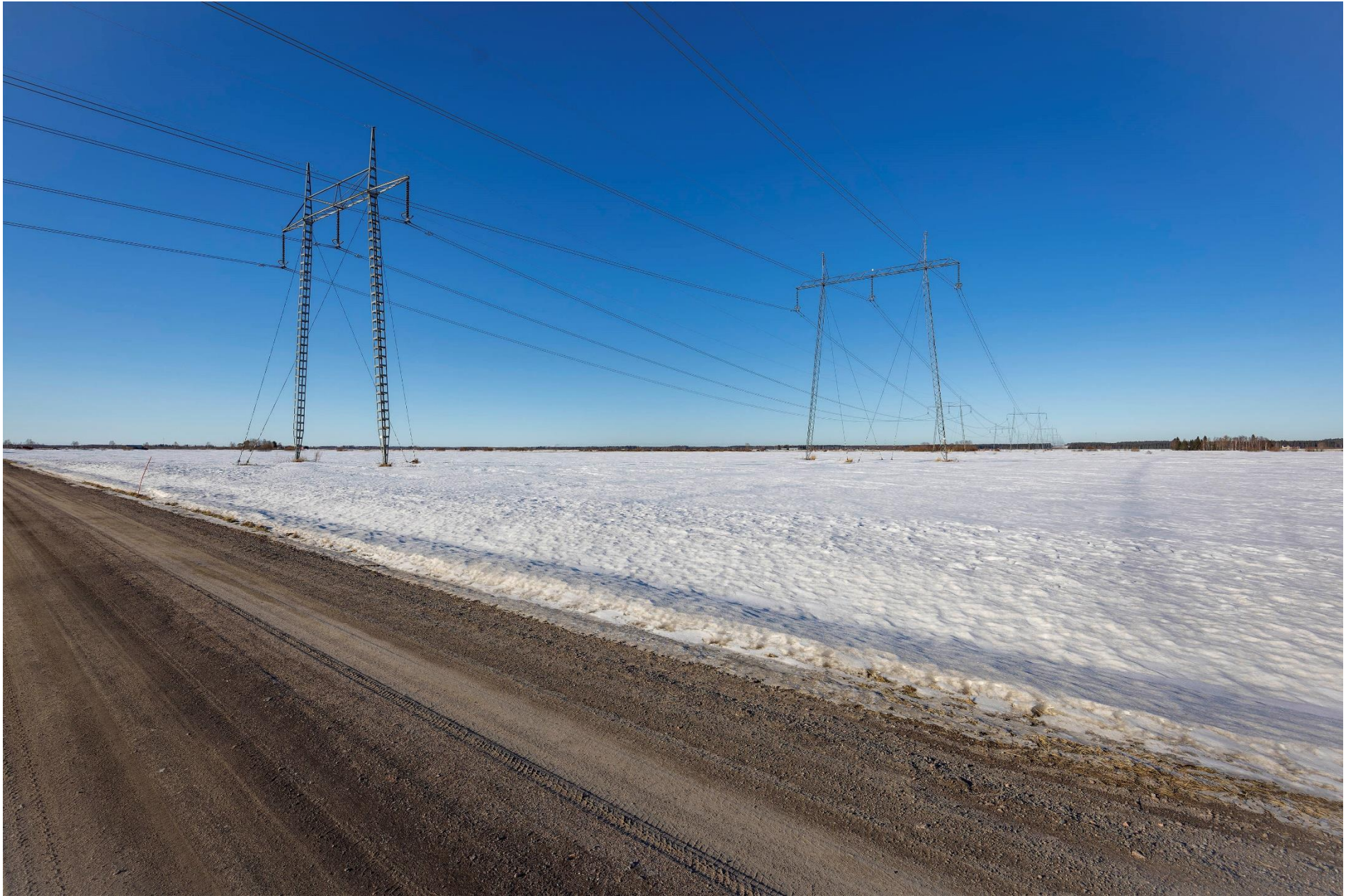
Kuva K. Näkymä nykytilanteesta Nikulantieltä. Kuvan objektiivi 16 mm.
