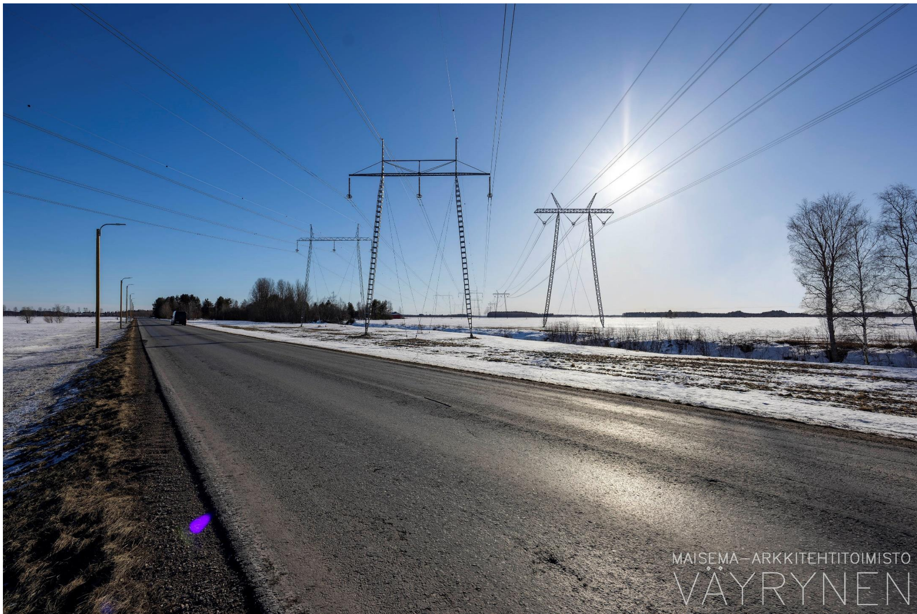
Kuva I. Havainnekuva Tyrnävänjoen ylityskohdasta vaihtoehdosta SVE5. Kuvan objektiivi 16 mm.
