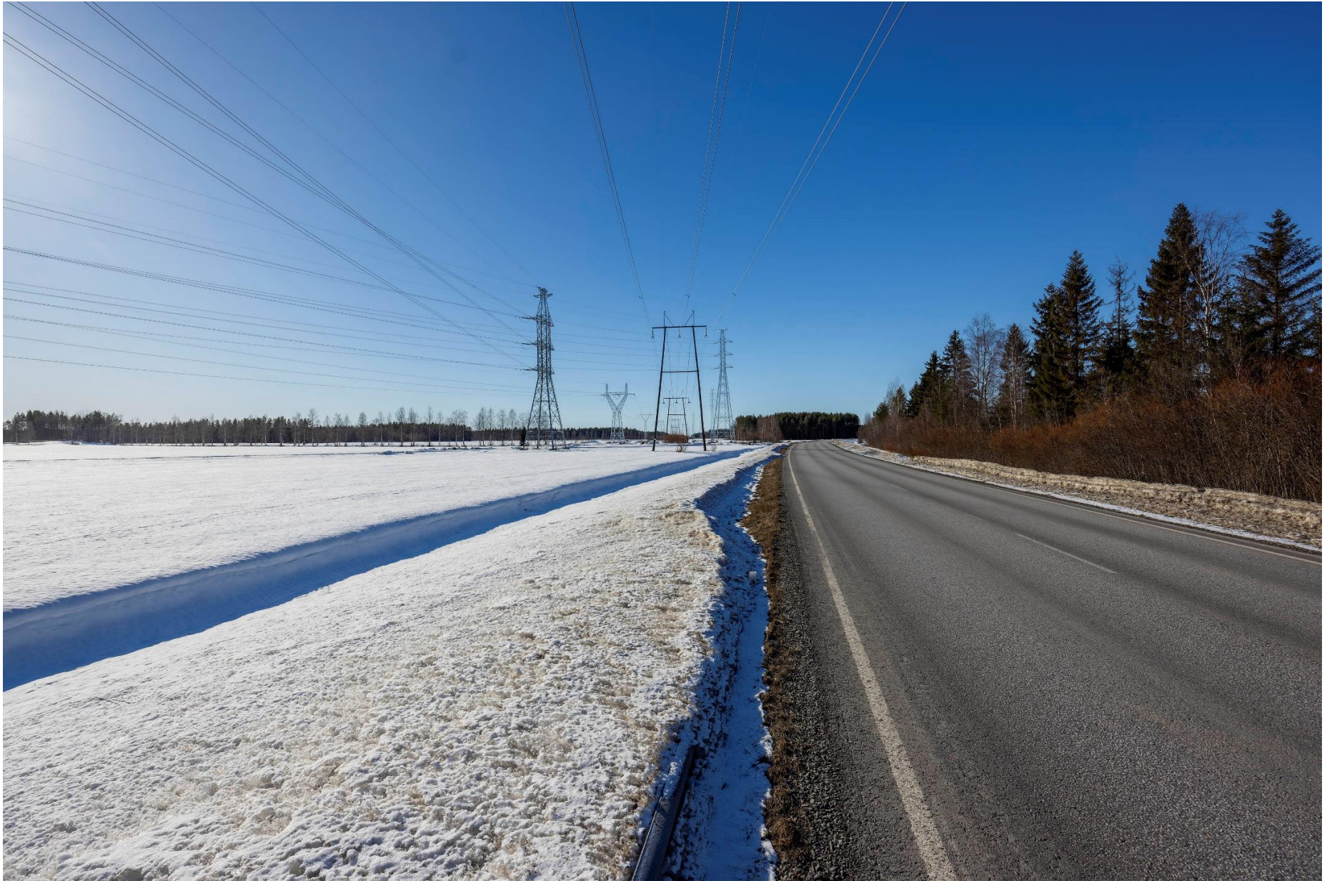
Kuva F. Näkymä nykytilanteesta Siikajoen sähköaseman kohdalta Ruukintieltä. Kuvassa näkyy uusien 110 kV voimajohtojen rakentamista ja vanhojen purkamista. Kuvan objektiivi 16 mm.
