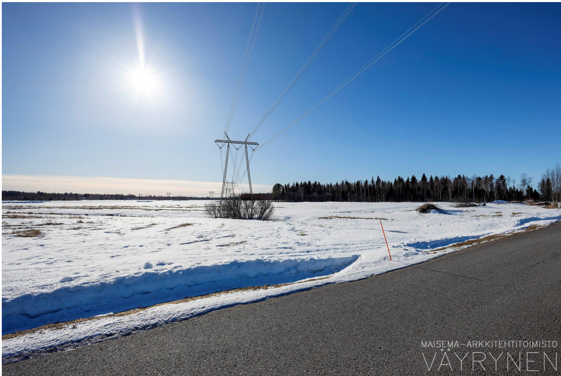
Kuva C. Havainnekuva Öystilänkorven pelloilta vaihtoehdosta SVE3 ja SVE5. Kuvan objektiivi 16 mm.
