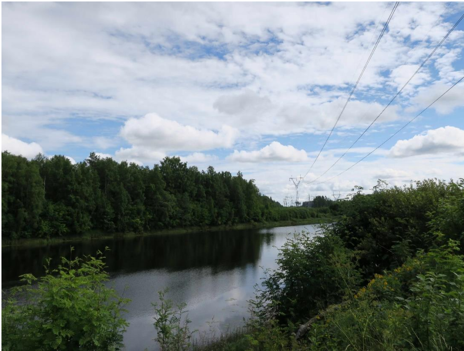
Kuva 3-4 Siikajoki reittivaihtoehdon SVE5 ylityskohdassa. Kuvassa näkyy nykyiset voimajohdot, SVE5 suunnitellaan niiden vasemmalle puolelle.
