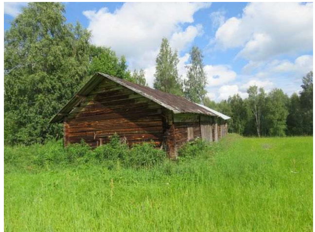
Sivurakennus kuvattu luoteeseen.
