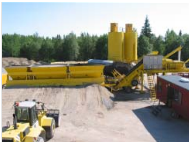
Kuva 12. Tieliikelaitoksen monitoimiasema, jolla stabilointi voidaan tehdä. Käsittely tehdään asfalttipintaisen käsittelykentän päällä.
