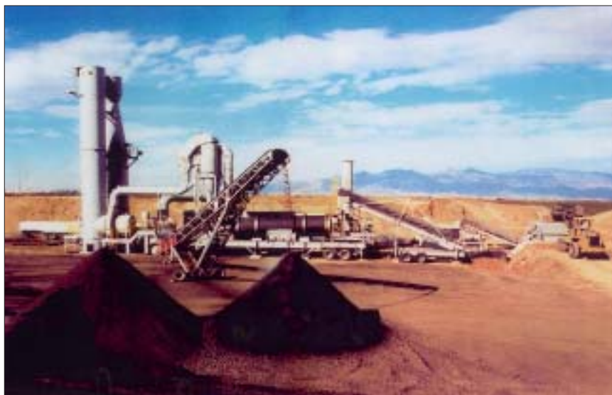
Kuva 13. Esimerkkikuva termisen desorption laitteistosta. Kuvasta poiketen käsittely tehdään asfalttipintaisen käsittelykentän päällä. Kuivat ja kuumina pölyävät puhdistetut maamassat kerätään suljettuihin kontteihin.
