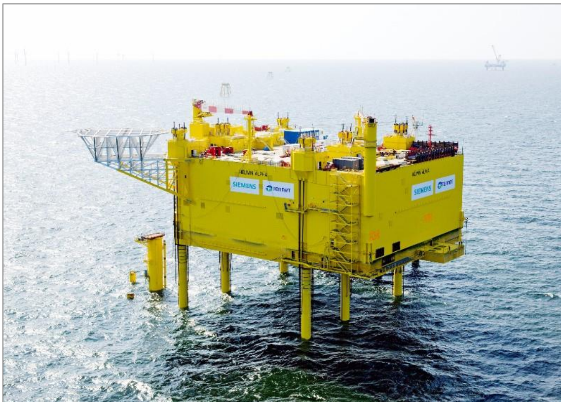
Figur 5-15. HVDC HelWin Alpha, ett exempel på en självutjämnande station som bogseras till position och lyfts upp med hjälp av lyftben (Overdick-offshore 2024).
