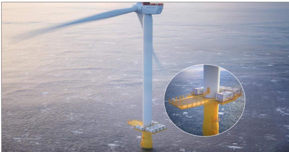
Figur 6-4. Exempel på vätgasproduktion vid foten av ett havsbaserat vindkraftverkstorn (Siemens-Gamesa 2021).
