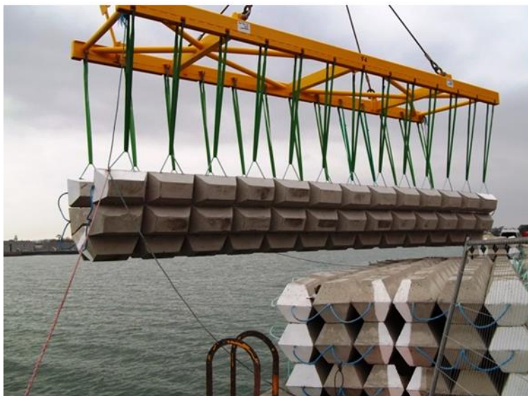
Figur 5–12. Exempel på ett betongskydd för att skydda en kabel (Subsea Protection Systems 2024).
