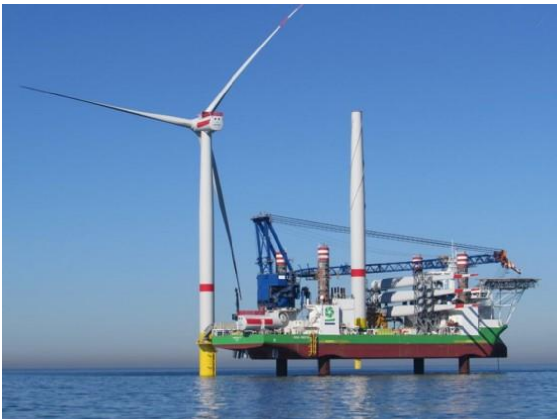
Figur 5-18. Installation av ett havsbaserat vindkraftverk på ett jack-up-fartyg (COWI 2021).
