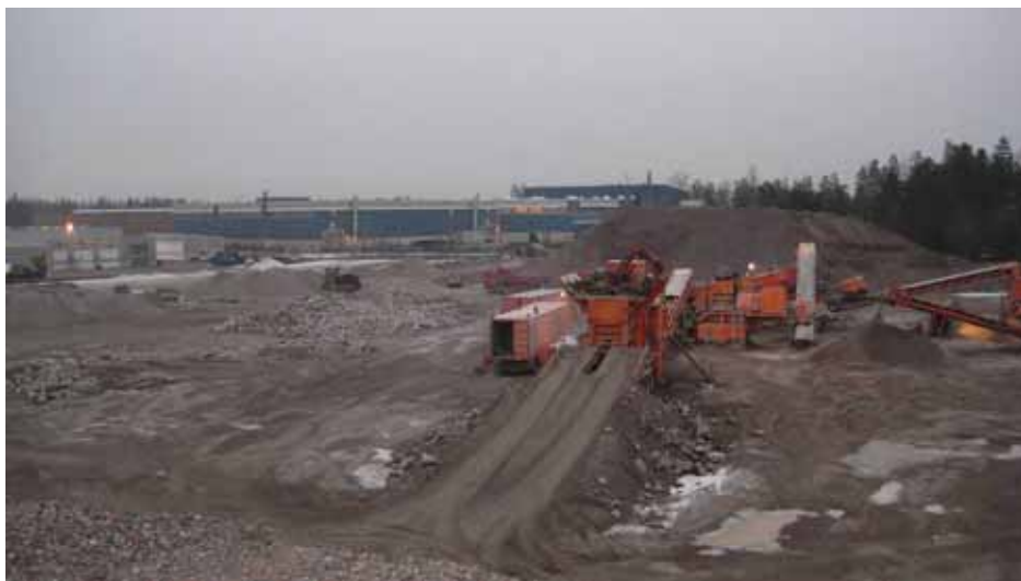
Kuva 4. Alueella murskataan ylijäämälouhetta (kuva 15.12.2008)
