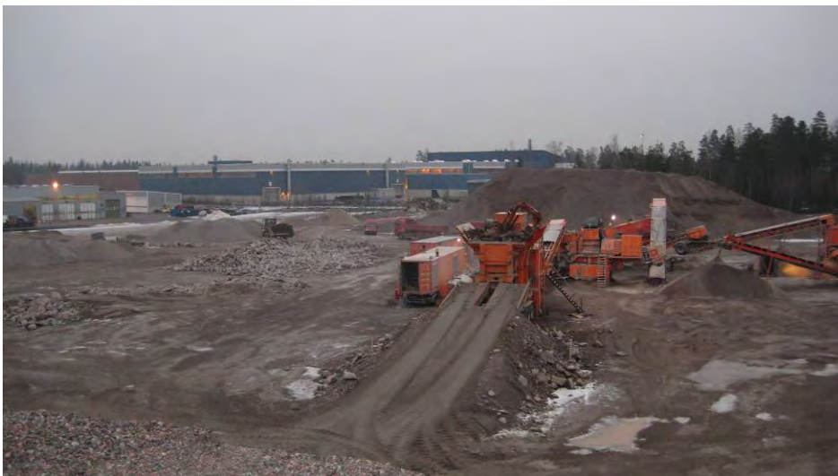
Kuva 6. Alueella murskattiin ylijäämälouhetta huhtikuuhun 2009 saakka (kuva 15.12.2008)
