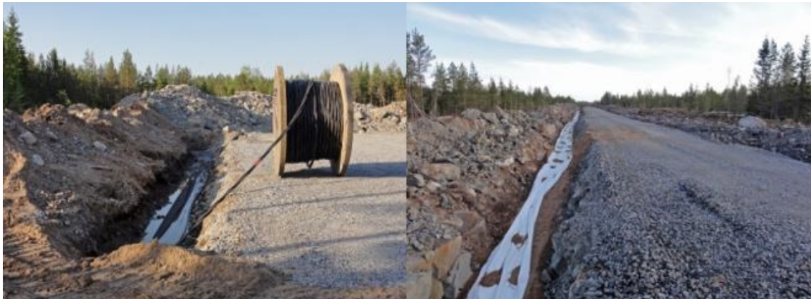
Kuva 4.11. Maakaapelit upotetaan huoltoteiden yhteyteen.
