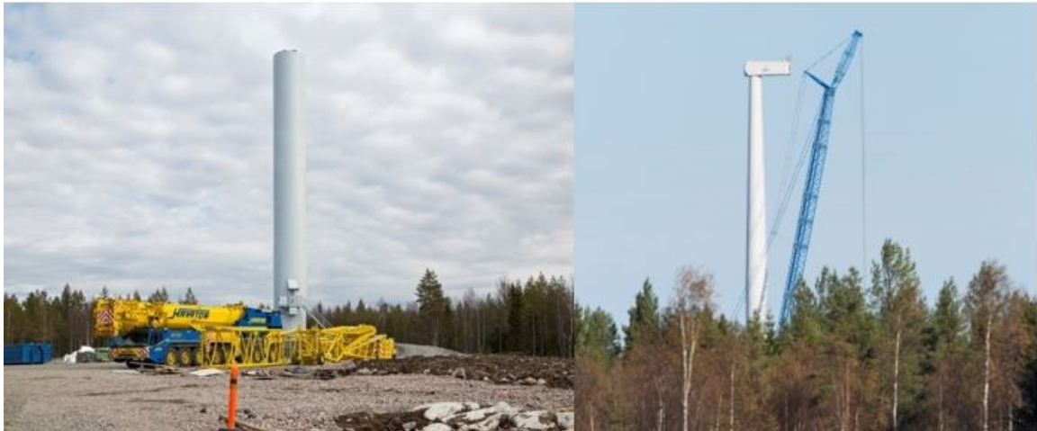
Kuva 4.13. Tuulivoimalan kokoamista.
