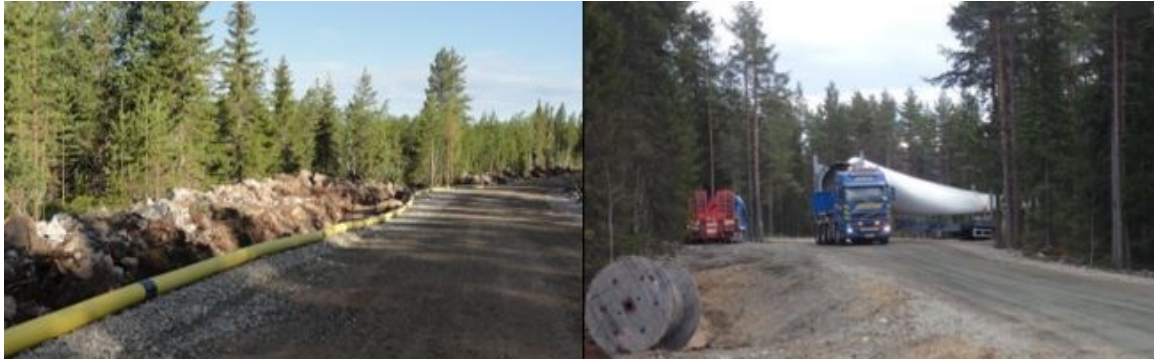
Kuva 4.8. Vasemmalla esimerkki tuulivoimapuiston rakennus- ja huoltotiestä. Teitä käytetään muun muassa betonin, soran ja voimaloiden komponenttien kuljetuksiin sekä tuulivoimapuiston käyttövaiheessa huoltoajoihin. Maakaapeli sijoitetaan ojakaivantoon tien reuna-alueelle. Oikealla tuulivoimalan osia kuljetetaan erikoiskuljetuksina.
