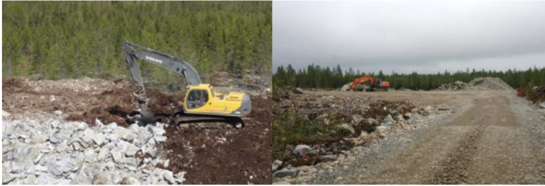
Kuva 4.10. Tuulivoimapuiston rakentaminen alkaa huoltoteiden ja pystytysalueiden rakentamisella.
