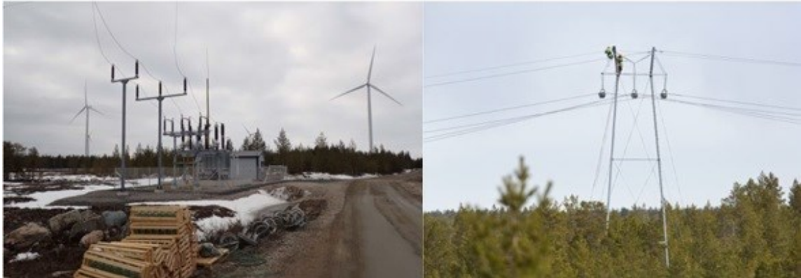
Kuva 4.15. Sähköaseman ja voimajohdon rakentamista.
