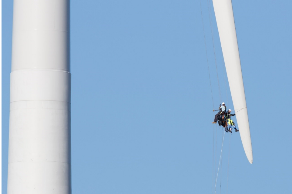
Kuva 4.17. Tuulivoimalan huoltotoimenpiteitä.
