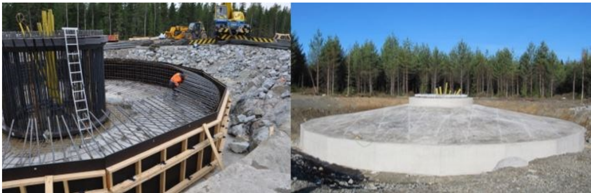
Kuva 4.12. Tuulivoimalan perustusten rakentamista (Leila Väyrynen, FCG).
