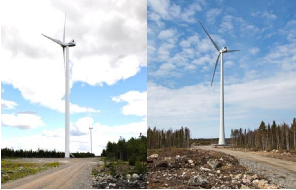
Kuva 4.2. Vasemmalla on esimerkki teräslieriötornista ja oikealla hybriditornista (Leila Väyrynen, FCG).
