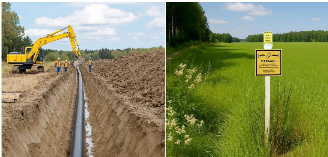
Kuva 3-7. Kuvat maakaasuputken asennuksesta. Putkikaivanto ja putken lasku pellolla, sekä pelto asennus- ja viimeistelytyöiden jälkeen seuraavana vuonna kuvattuna.
