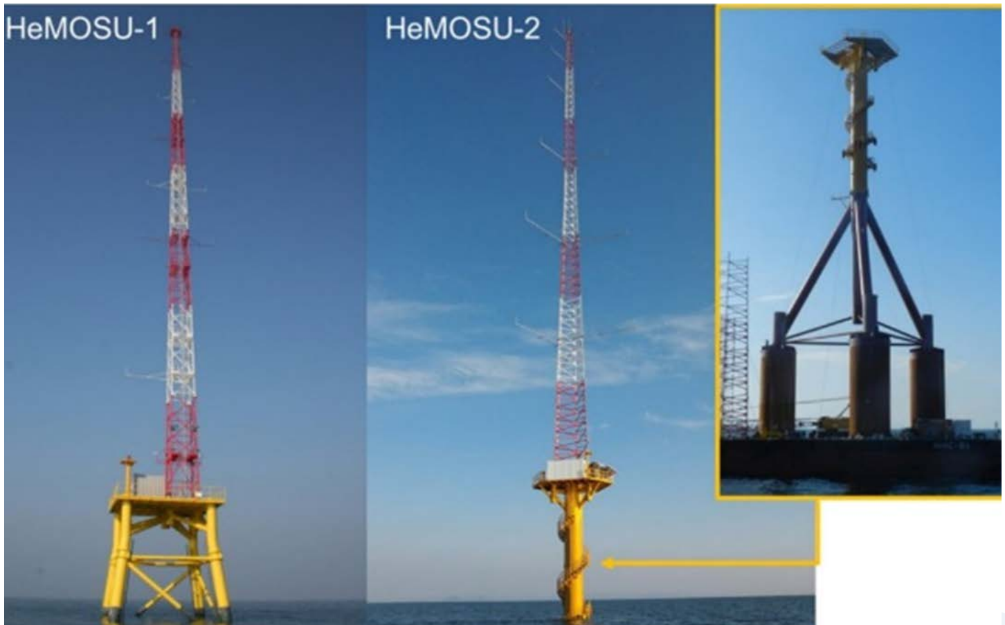
Kuva 12. Mittausmastojen vaihtoehtoiset perustustyyppit (Oh, Nam, Ryu, Kim, & Epureanu, 2018).
