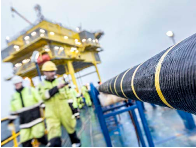
Kuva 10. Kuva sähkökaapelin asentamisesta muuntaja-aseman lähelle. ©wpd
