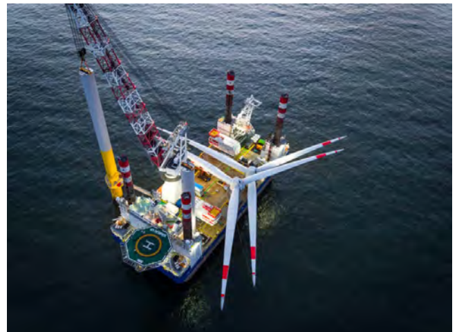
Figur 14. Installation av ett havsbaserat vindkraftverk. ©wpd
