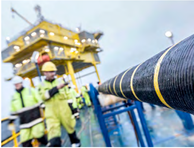
Figur 10. Bilden visar anläggning av elkabel i närheten av en transformatorstation ©wpd
