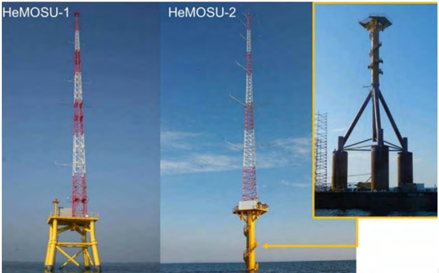
Figur 12. Alternativa fundamenttyper för mätmaster (Oh, Nam, Ryu, Kim, & Epureanu, 2018).
