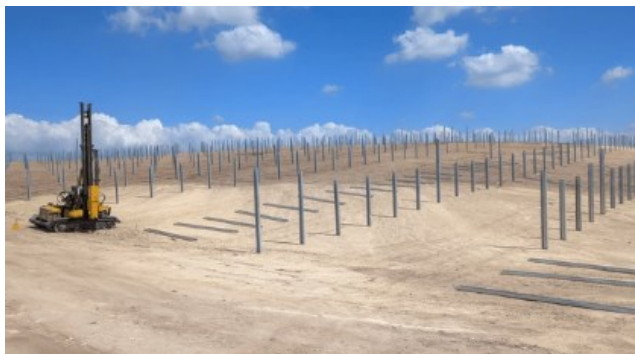
Bild 4.5 Till vänster ett exempel på en grund med skruvpålar. Till höger ett exempel på en slagpålad grund. (Bilder: Fortum)
