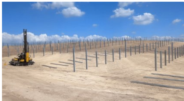
Kuva 4.5 Vasemmalla esimerkki ruvipaalausperustuksesta. Oikealla esimerkki lyöntipaalausperustuksesta. (Kuvat: Fortum)
