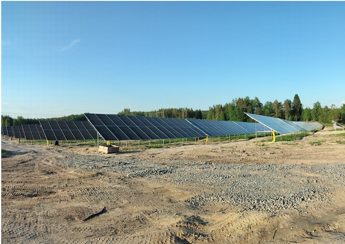
Kuva 4.14 Esimerkki rakenteilla olevasta aurinkovoima-alueesta. Kuvassa Kitusenkulman aurinkovoima-alue Virroilla. (Kuva: FCG)
