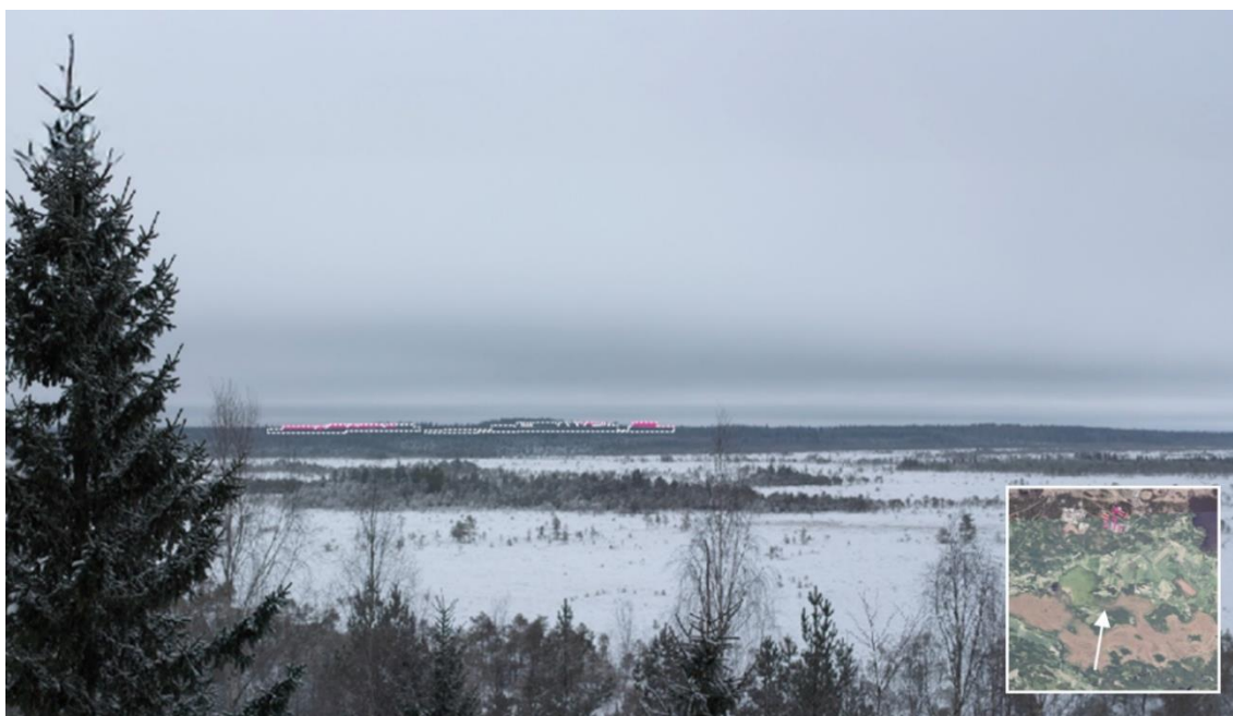
Kuva 14-10 Näkymä datakeskuksen suuntaan Torronsuon lintutornista. Datakeskuksen rakenteet korostettu kuvassa pinkillä havaitsemisen helpottamiseksi.
