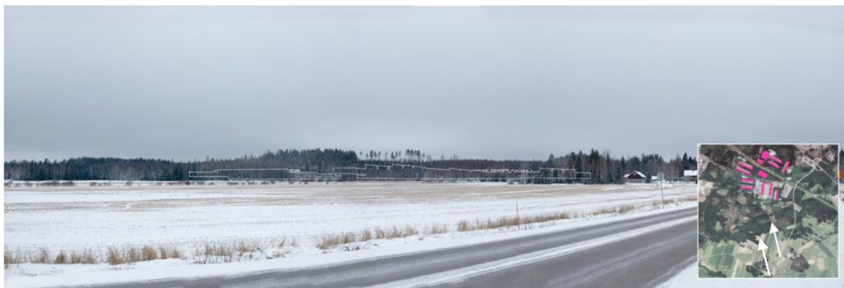
Kuva 14-5 Näkymäalueanalyysin mukaan Sukulan maakunnallisesti merkittävän kulttuuriympäristön alueelta voisi hahmottaa datakeskuksen piippuja. Havainnekuvatarkastelun perusteella jopa laskennallisesti parhaalta katselupisteeltä piippujen huiput jäivät lopulta puuston peittoon. Varsinaiselta arvoalueelta näkymä on entistä peitteisempi.
