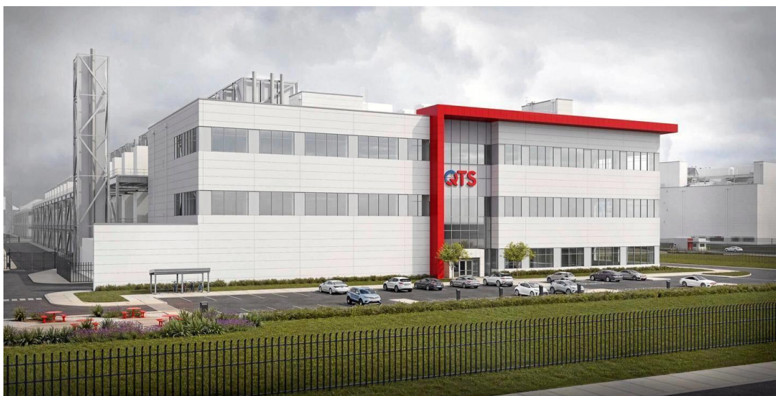
Kuva 6-1 Esimerkkikuva tyypillisestä datakeskuksesta. Kuvassa rakennuksen vasemmalla puolella on generaattorialue kiinni rakennuksessa. Lähde: QTS
