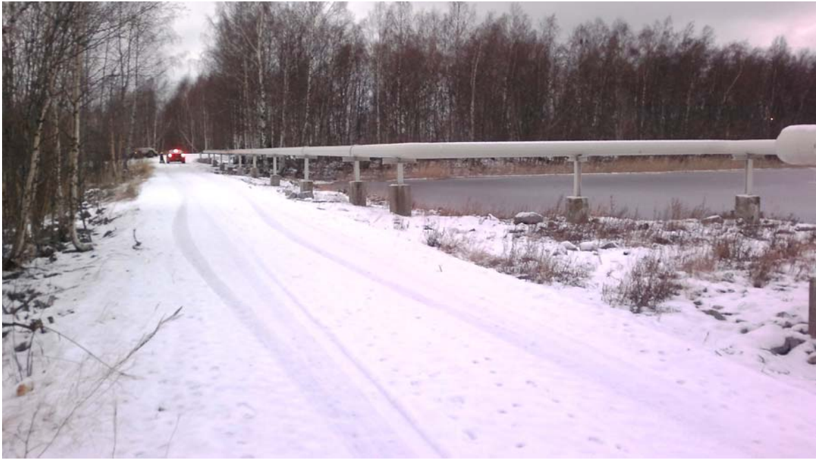
Kuva 54. Takalahden eteläpuolelle rakennettu pengertie. Takalahti sijoittuu kuvassa oikealle, meri vasemmalle (kuva: WSP/Satu Pietola). Kuvassa näkyy myös polttonesteiden huoltovarmuusvarastolle johtava putki.
