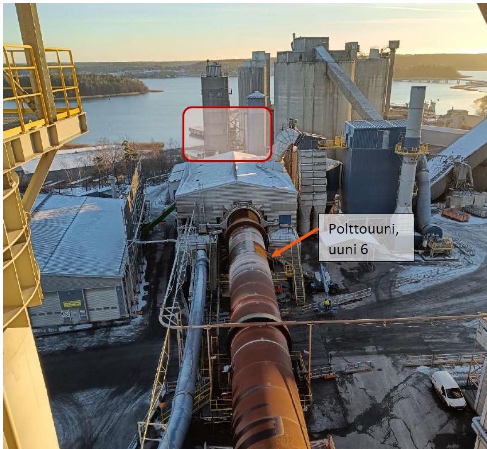
Kuva 4-2. Kuivaimen sijainti havainnollistettu punareunaisella rajauksella.
