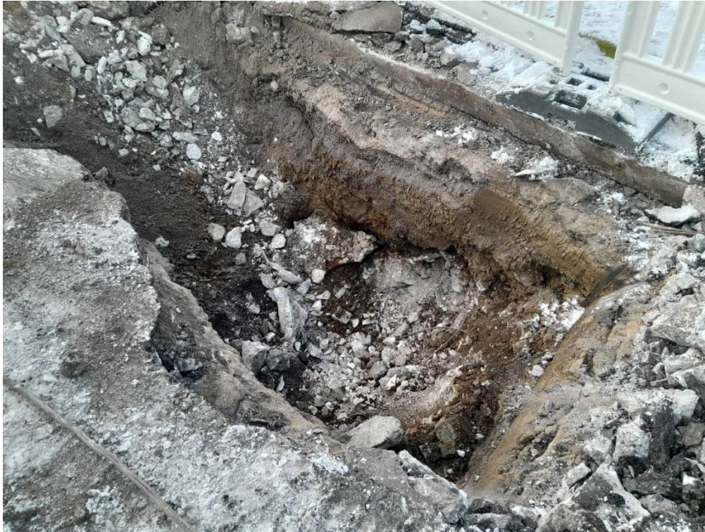
Kuva 1: Koekuoppa KK28 hulevesilinjalla. Kuvattu 29.11.2023.
