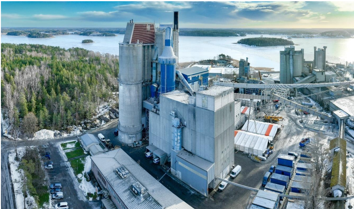
Kuva 3-7. Kaksiosainen homogointisiilo, kuvan vasemmalla puolella oleva betonilieriö.
