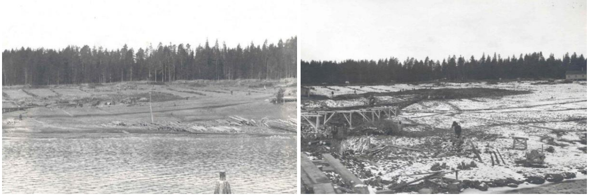
Kuva 14. Finnsementin sementtitehtaan alue ennen tehtaan toiminnan aloittamista 1910-luvun alusta. (Kuvat Nordkalk Oy).
