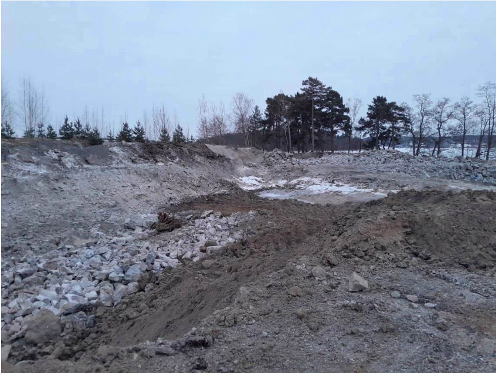
Kuva 3: Niemen isomman altaan kaivutyöt. Kuvattu 7.2.2024.
