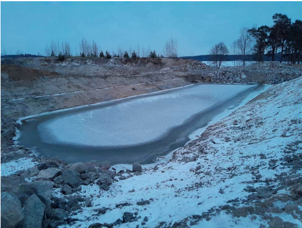
Kuva 4: Pienempi allas, kaivut valmiit. Kuvattu 7.2.2024
