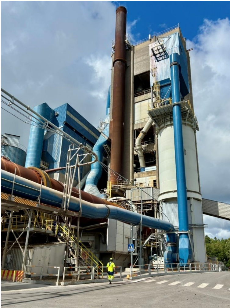
Kuva 3-8. Nelivaiheinen syklonitorni (kuva 3-3 kohta 6), ja piippu uunista tuleville savukaasuille. Tästä piipusta tehdään kaikki päästömittaukseen liittyvät mittaukset.
