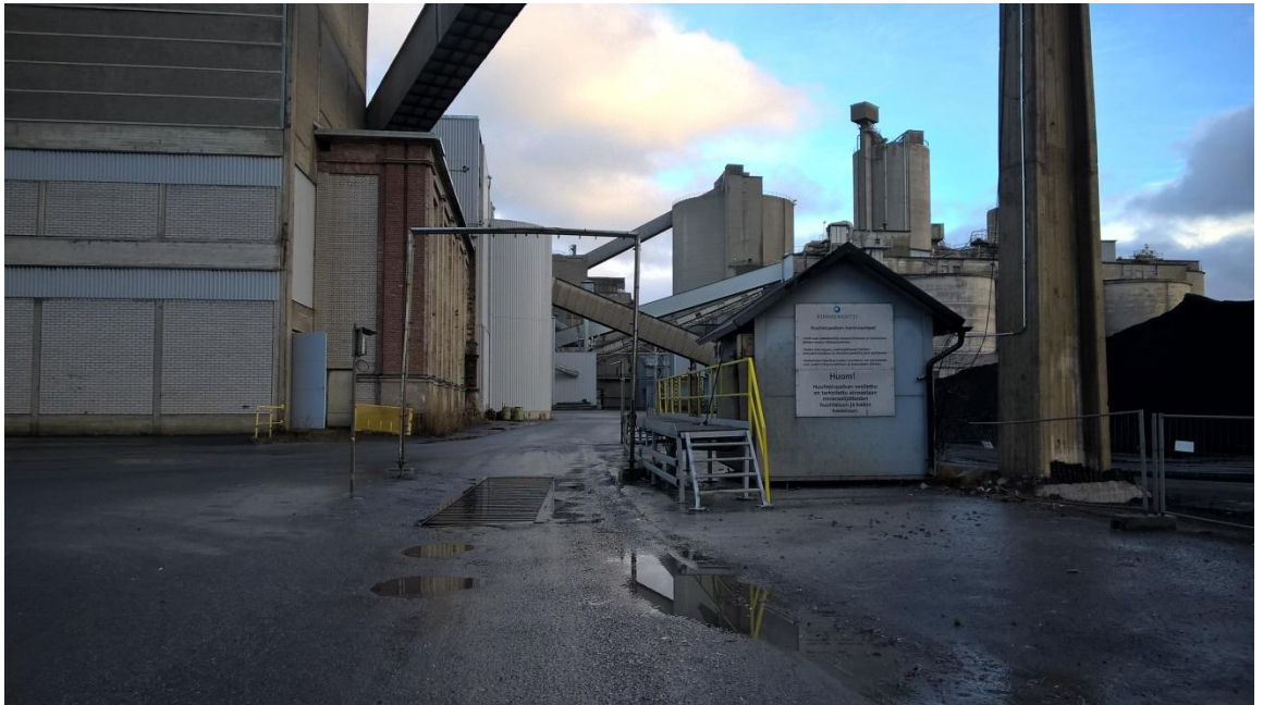
Kuva 16. Autonpesupaikka ja öljynerotuskaivon kannet.
