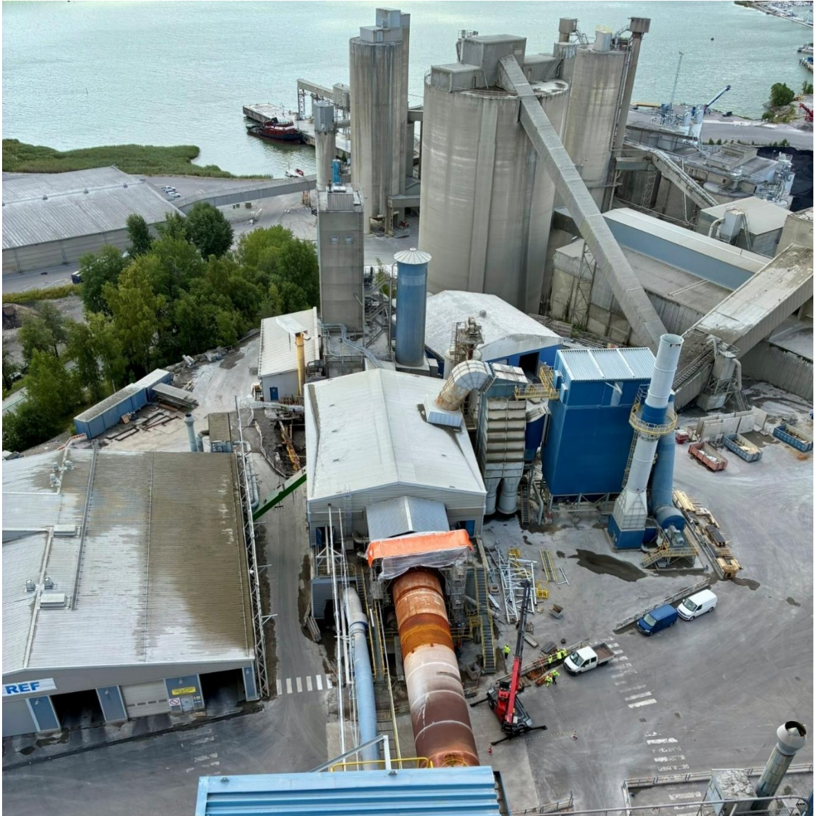
Kuva 3-9. Kiertouuni (kuva 3-3, kohta 7) on kuvan alaosassa näkyvä ruskea-valkoinen putki.
