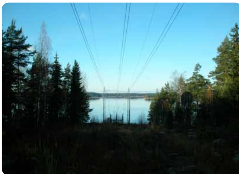
Kuva 35. Tolkkisten terminaalialueen halki kulkee voimajohto, joka yhdistyy Kilpilahteen merenalaisella kaapelilla (kuva: Reetta Suni)
