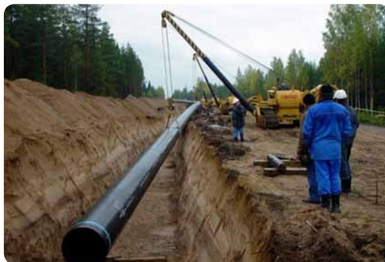
Kuva 21. Esimerkki kaasuputken laskusta (kuva: Gasum)
