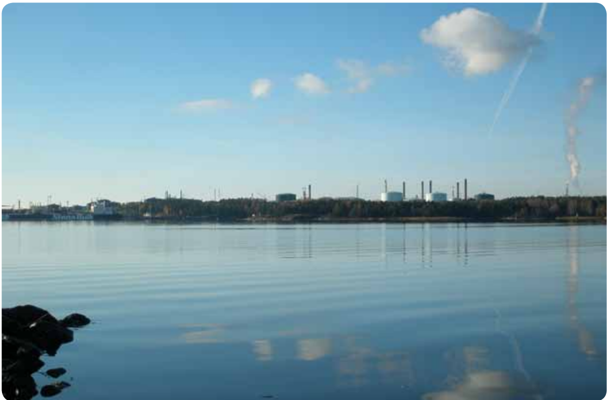
Kuva 76. Kilpilahden öljynjalostamon satama (Sköldvikin satama) on tonnimääräisesti Suomen suurin satama. Kuva terminaalialueelta Neste Oilin öljynjalostamolle. (kuva: Reetta Suni)
