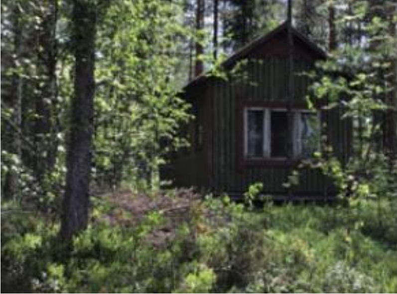
Kuva 15-5. Inkoossa kiinteistöllä 149-476-5-9 Stenbergskogen sijaitseva käytöstä poistunut rakennus.
