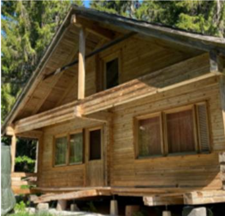
Kuva 15-4. Siuntiossa kiinteistöllä 755-436-2-60 Kalliovuori sijaitseva purkukuntoinen ja käytöstä poistunut rakennus.
