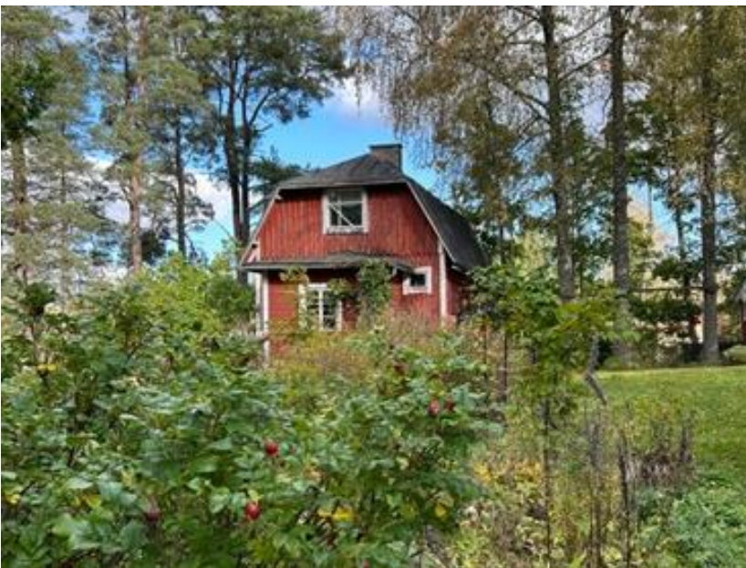
Kuva 15-6. Siuntiossa kiinteistöllä 755-459-1-625 Sjundby gård sijaitseva käytössä oleva asuinrakennus. Rakennus on edelleen asuinkäytössä.
