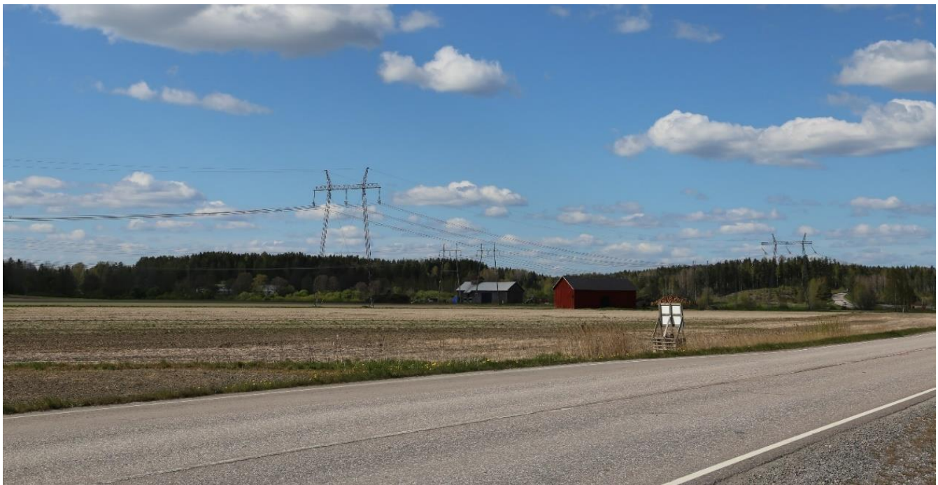
Kuva 12-48. Valokuva Eteläiseltä Salontieltä lännen suuntaan, missä ovat nykyiset kaksi 110 kV:n voimajohtoa sekä yksi 400 kV voimajohto rinnakkain. Uusi, suunniteltu voimajohto (osuus L_R-S) sijoittuisi kuvassa näkyvän voimajohdon taakse (länsipuolelle). Kuvauspaikka on esitetty kartoilla numerolla 20 (liite 6). Kuvauspaikasta ei ole tehty havainnekuva.
