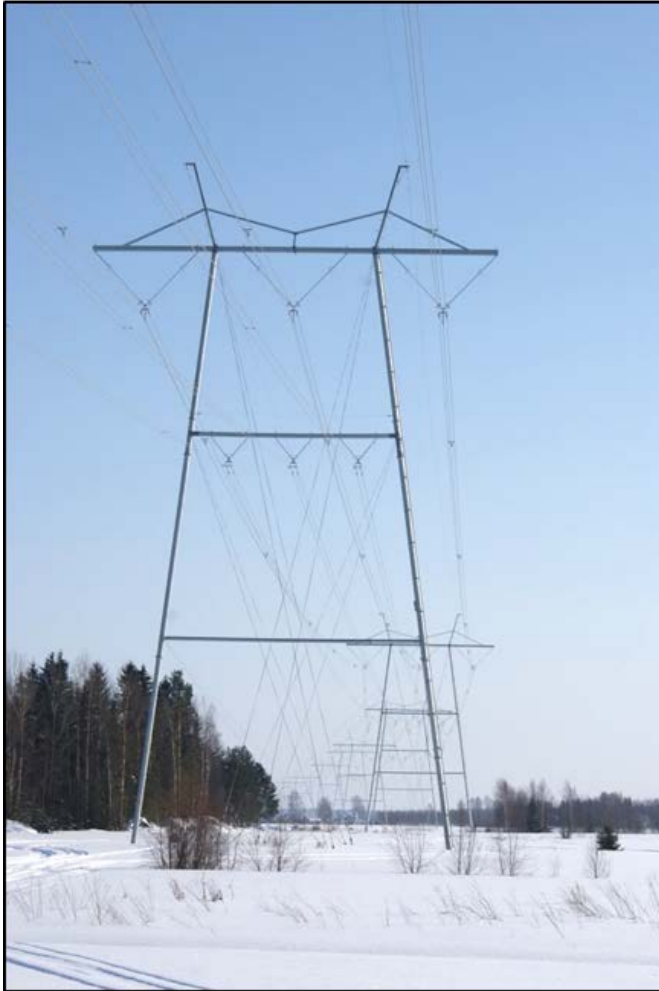
Kuva 4-8. Esimerkkikuvat eri pylvästyypeistä. Vasemmalla perusratkaisun mukainen 400+110 kilovoltin haruksin tuettu portaalipylvä ja oikealla vapaasti seisova harukseton peltopylvä.
