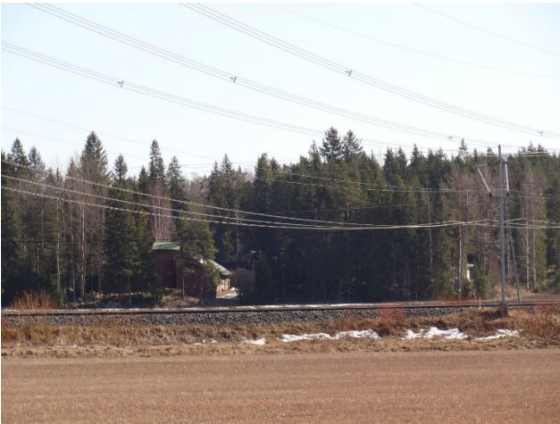
Kuva 8-16. Voimajohdon reunavyöhykkeelle sijoittuva asuinrakennus Isänmaassa.
