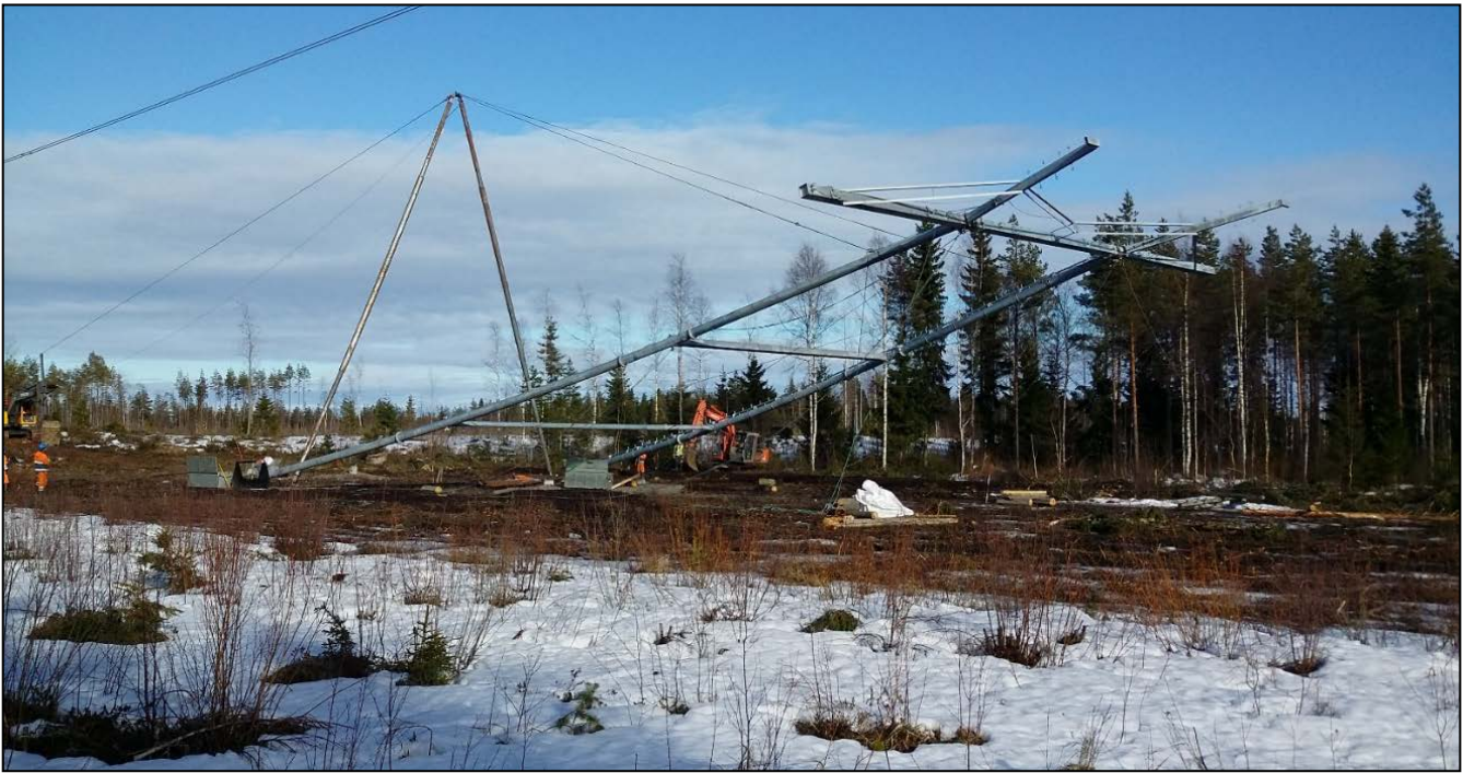
Kuva 2-6. Voimajohtopylvään pystytys.
