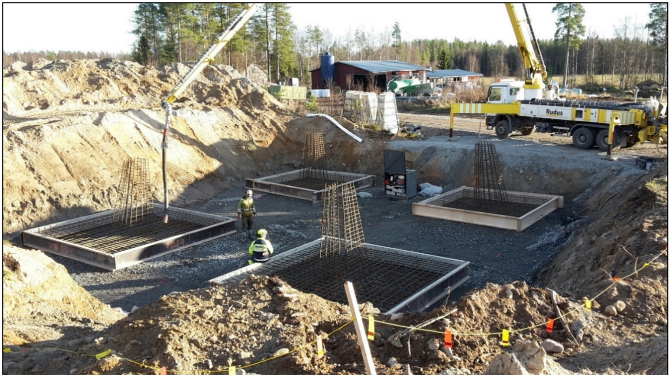
Kuva 2-5. Vapaasti seisovan pylvään perustuksen pohjatöitä.
