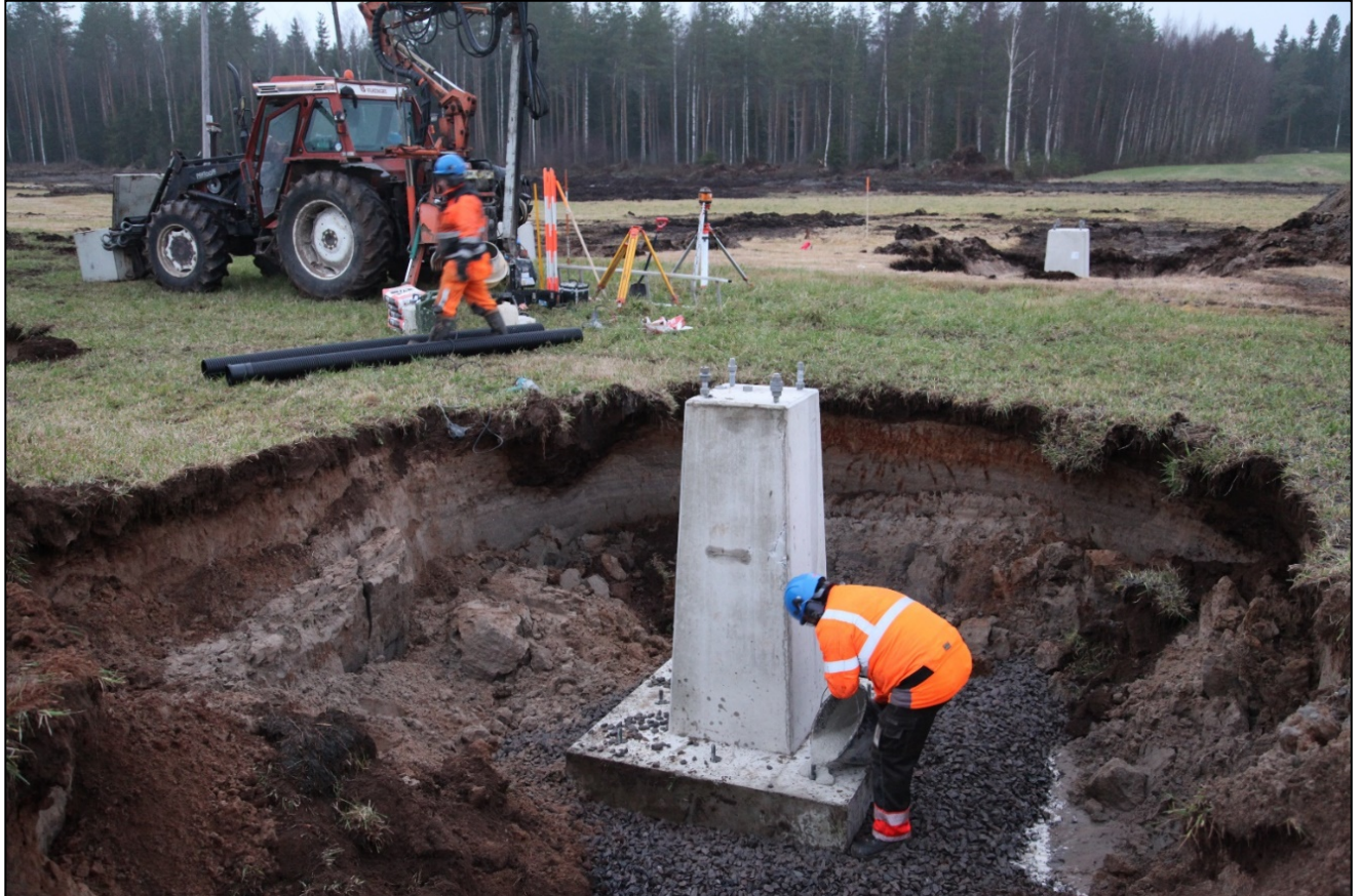
Kuva 2-4. Pylvään perustuselementin asentaminen.
