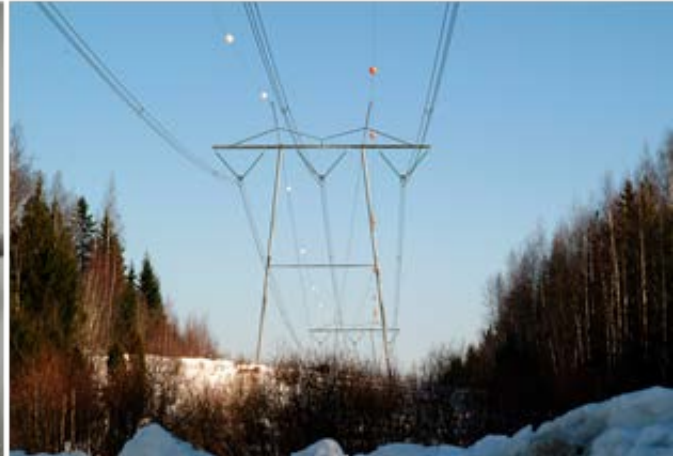
Kuva 9-28. Lintujen törmäysriskiä voidaan pienentää merkitsemällä ukkosjohtimet riskialttiissa kohdissa.
