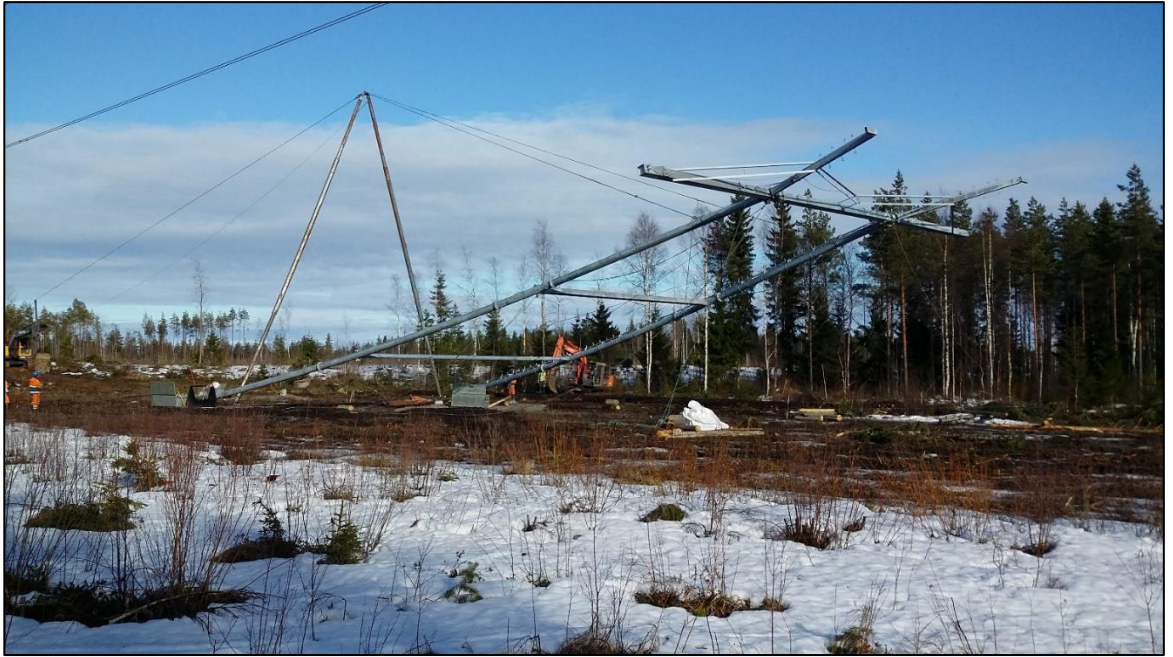
Kuva 3-7. Voimajohtopylvään pystytys. Bild 3-7. Resning av en kraftledningsstolpe.
