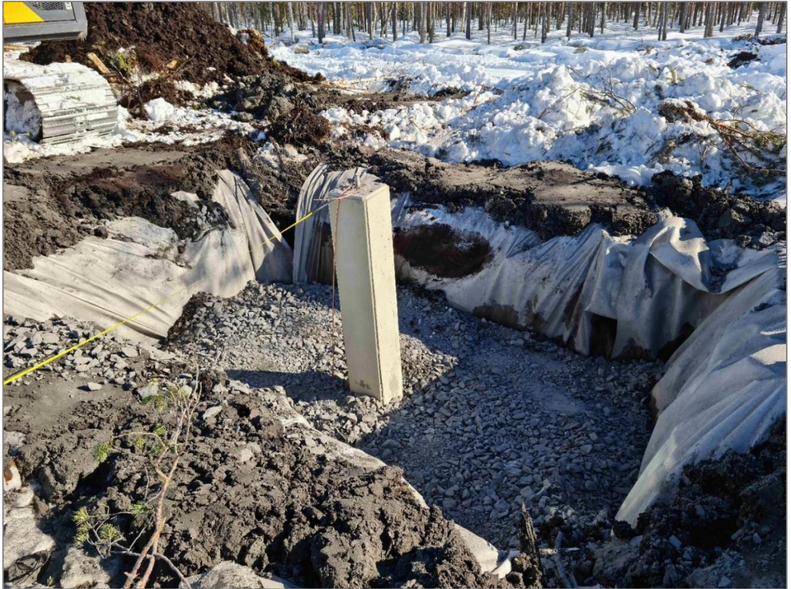
Kuva 3-4. Pylvään perustuselementin asentaminen. Bild 3-4. Installering av stolpfundament.
