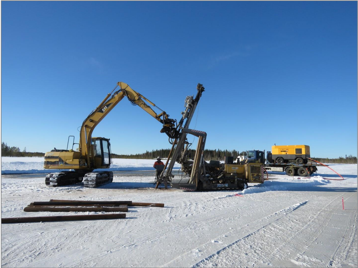
Kuva 3-6. Porapaaluperustuksen tekoa suoalueella, jossa työalue on jäädytetty. Bild 3-6. Konstruktion av borrade pålfundament på ett myrområde där arbetsområdet är nedfruset.
