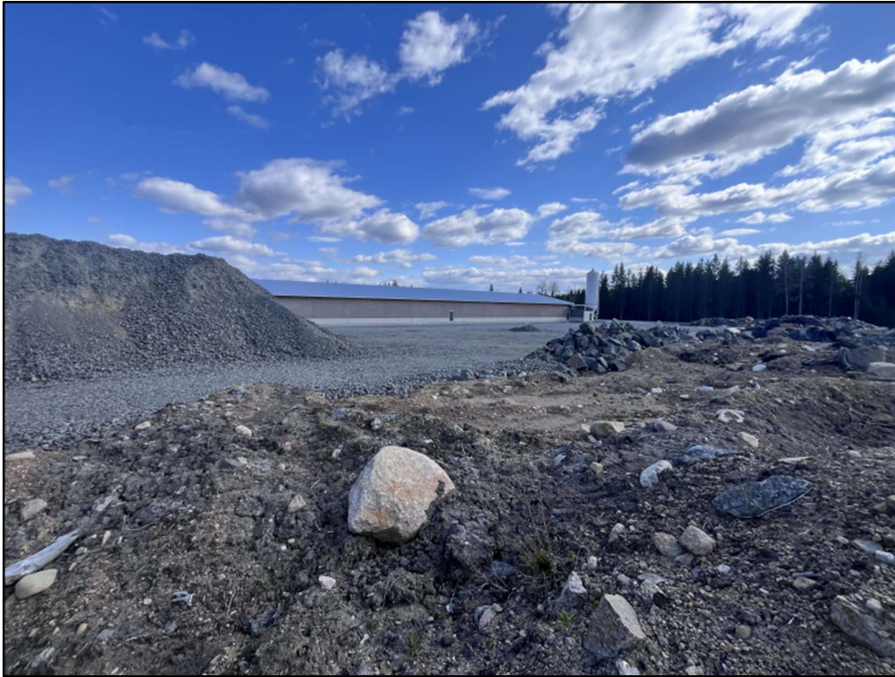
Kuva 71. Kuva suolta päin otettuna, kuvassa näkyy VE0 mukainen kanala. Hankealue on pitkälti jo rakennettua.
