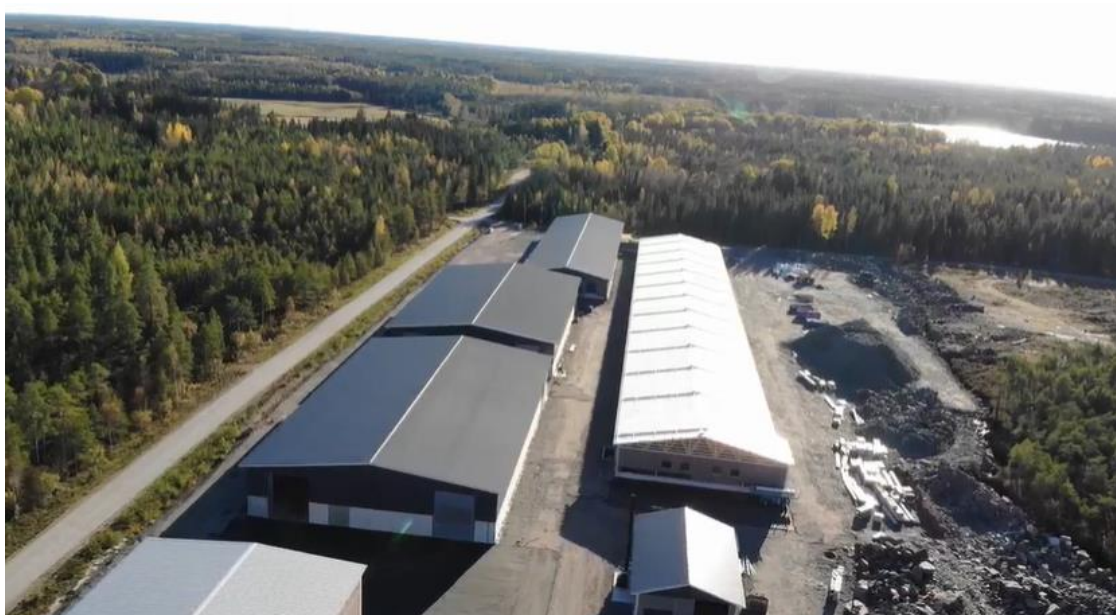
Kuva 19. Ilmakuva hankealueen yltä etelän suuntaan. VE1 ja VE2 uudet kanalat sijoittuisivat kuvassa valkokattoisena näkyvän kanalan oikealle puolelle.
