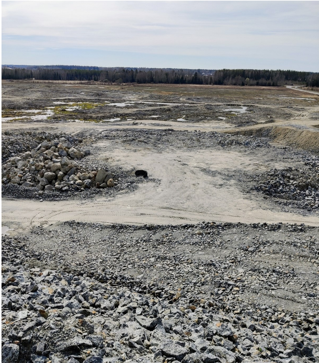
Kuva 11-3. Korttelin 16 nykytilaa. Kuva suunnattu hankealueen koilliskulmasta kohti Vaasan lentoasemaa. Kuva on otettu 10.5.2023.
