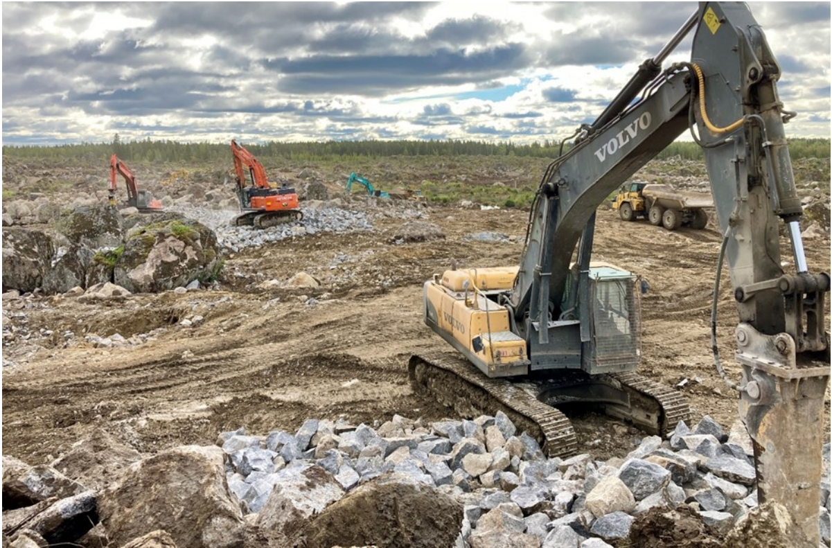
Kuva 7-1. Hankealueella käynnissä olevat rakennustyöt syyskuussa 2021.
