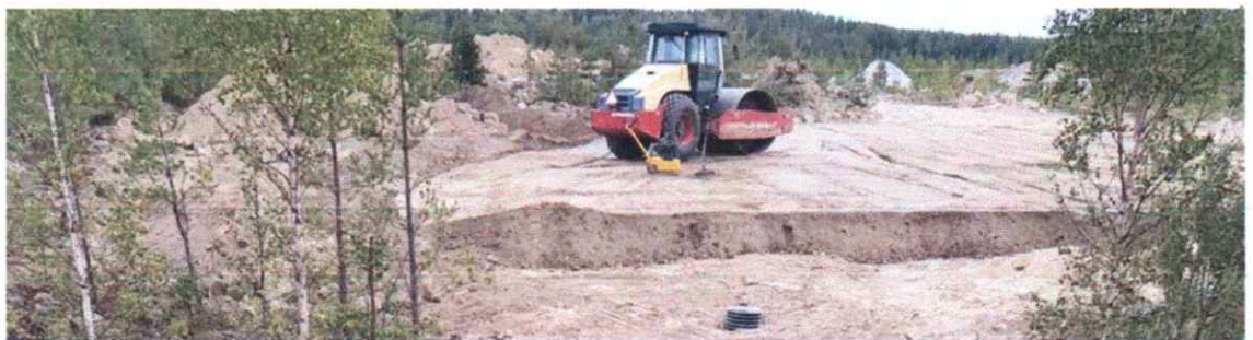
Kuva 6: Kuva täräjästä rakennettaessa testialueita toisessa hankkeessa.
