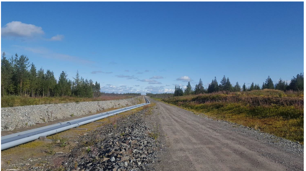
Figur 10: Foto från väg 99 i östlig riktning som visar pumpedningar för anrikningssand, transportväg till sand- och klarningsmagasin (Golder, 2018).
