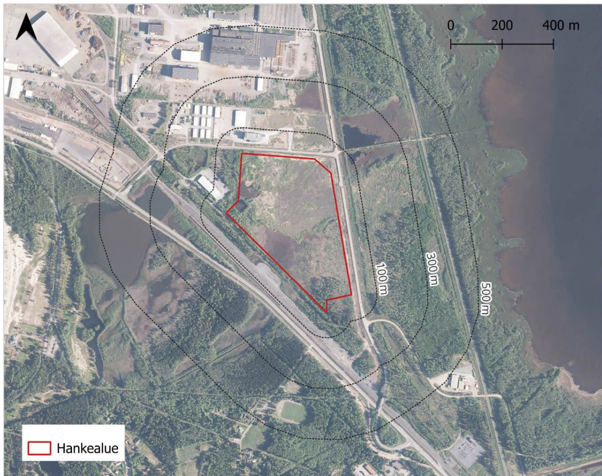
Kuva 1-4 Ilmakuva Porin hankealueesta (Maanmittauslaitos 2025).
