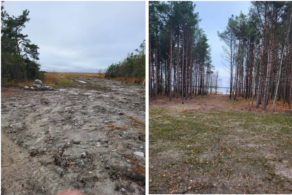
Kuva 5. Piensalmen toisen 110 kV merikaapelin rantautumispakka Muhussa (vasemmalle) ja Orissaaressa (oikealla) asentamisen jälkeen (Elering AS, 06.11.2024)
