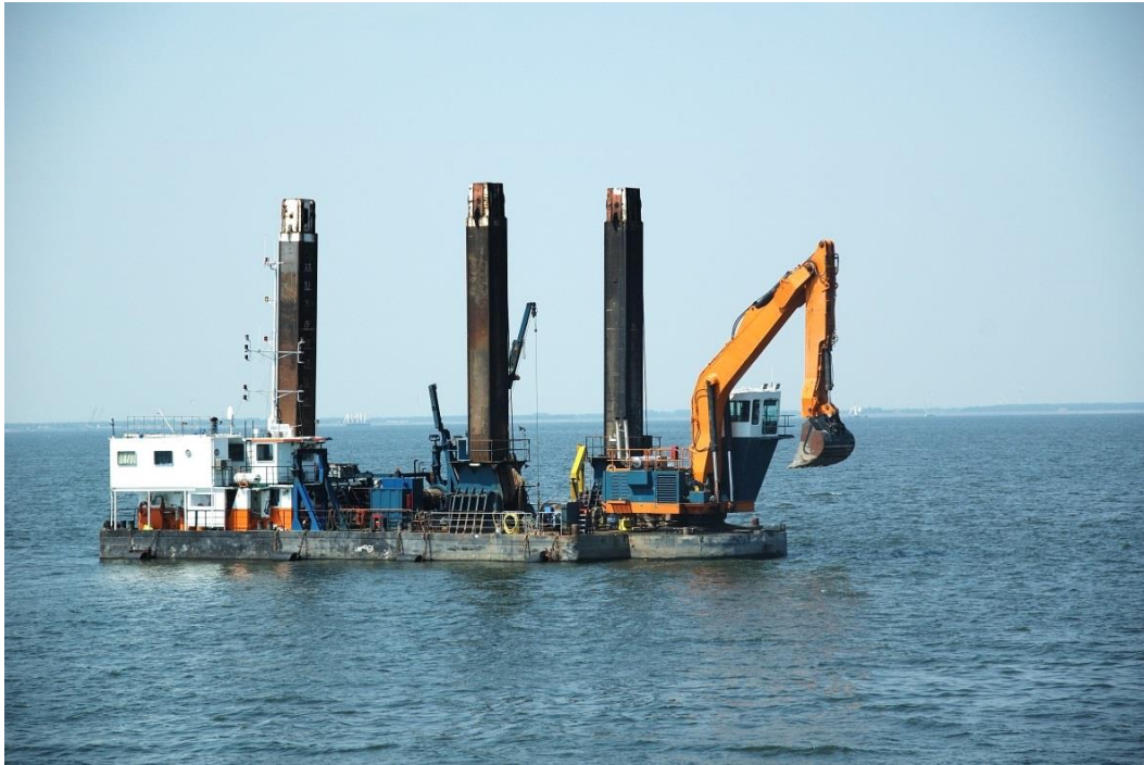
Kuva 1. Kaapeliojan kaivaminen matalassa vedessä 2
