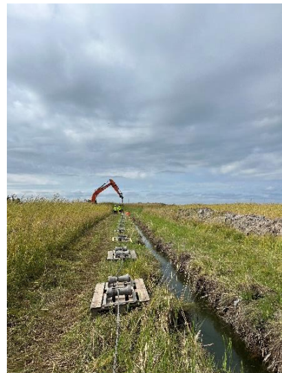
Kuva 4. Piensalmen toisen 110 kV merikaapelin asennus Muhun rannikolla avoimella menetelmällä (Skepast&Puhkim OÜ, 21.08.2024)
