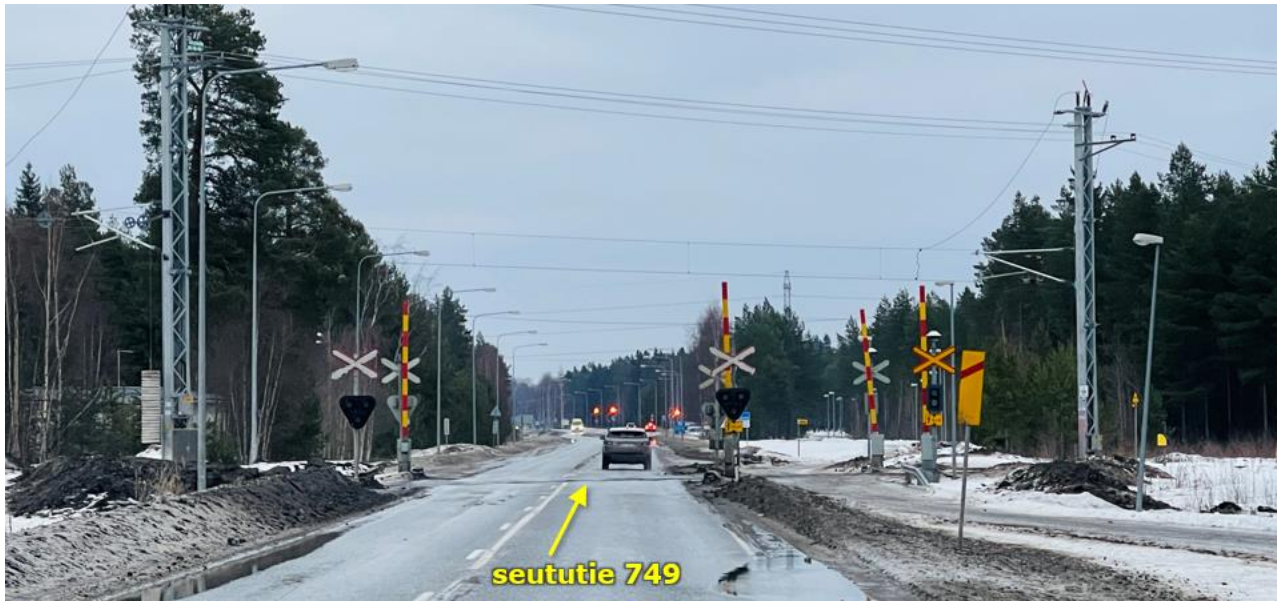
Kuva 7: Kokkolassa Varikon tasoristeyksessä on ajojohtimien nostolaitteisto, joka mahdollistaa 8 m korkeat kuljetukset ilman rakenteiden purkamista.
