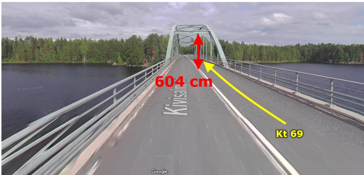
Kuva 10: Matala silta kantatiellä 69 (Google Maps 2024).
