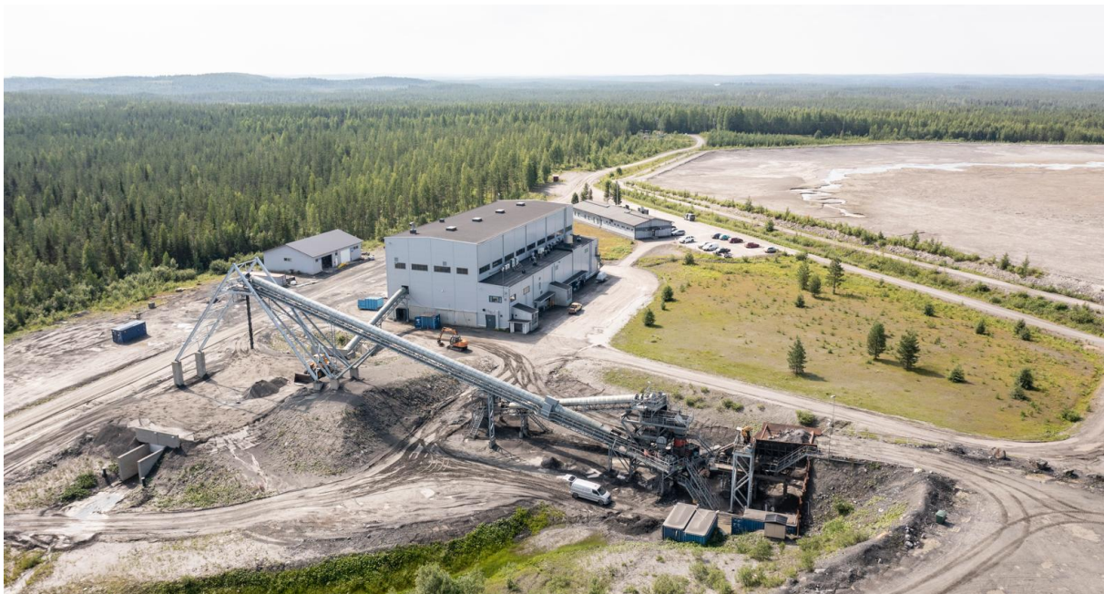
Kuva 9-1. Rikastamorakennus kaivosalueella ja oikealla rikastushiekka-allas (kuva Endomines Oy).
