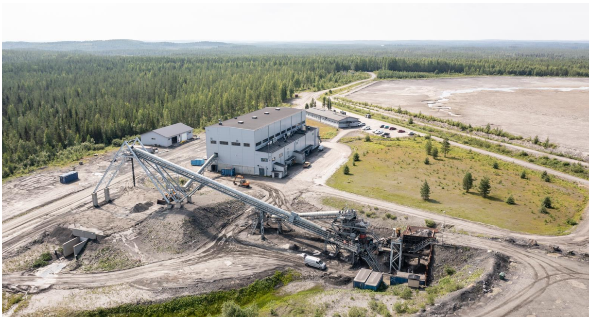
Kuva 10-1. Rikastamorakennus kaivosalueella ja oikealla rikastushiekka-allas (kuva Endomines).
