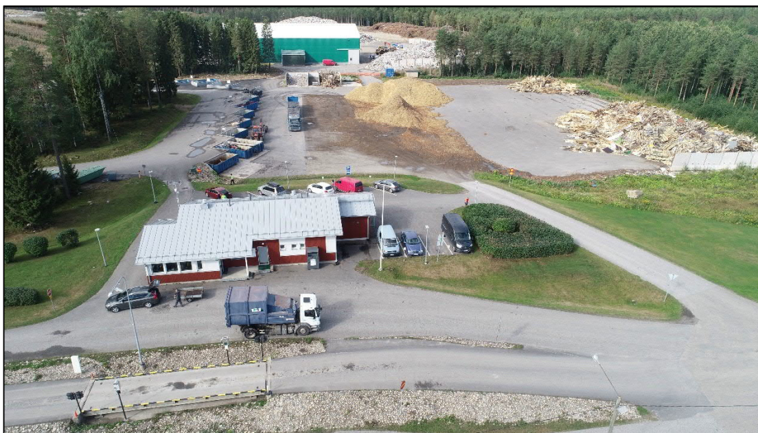
Kuva 4-10. Jätekeskuksen toimistorakennus ja vaaka-asema.
