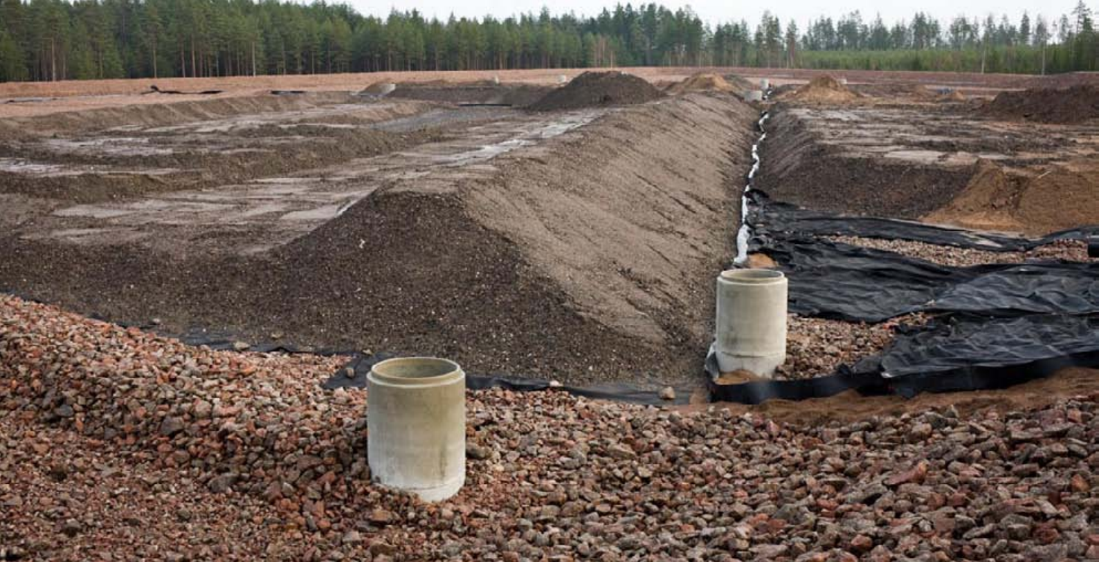
Kuva 5-9. Loppusijoitusalue, jossa etualalla näkyy kuivatuskerrossepeliä. Kuvassa keskellä jätemateriaalia sijoitettuna suodatinkankaan päälle (suodatinkangas on kuvassa näkyvä musta materiaali). Kuivatuskerroksen alla olevat tiivistysrakenteet eivät näy kuvassa.
