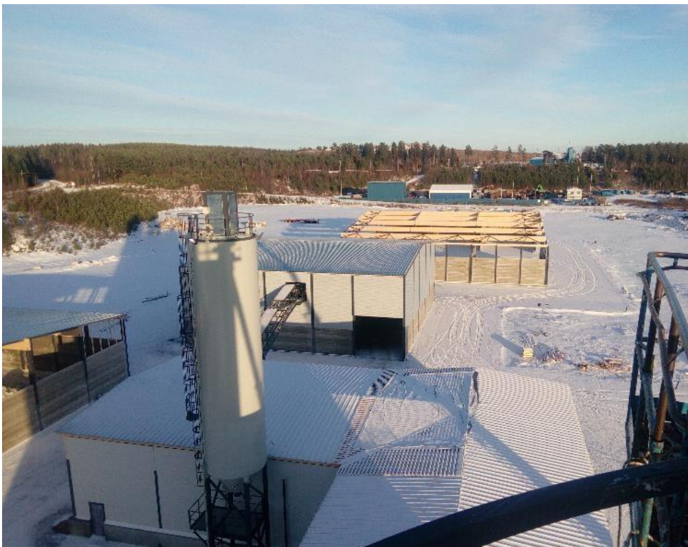
Kuva 48. Kuva laitosalueelta pohjoiseen/koilliseen päin siilon yläosasta katsottuna joulukuussa 2016.
