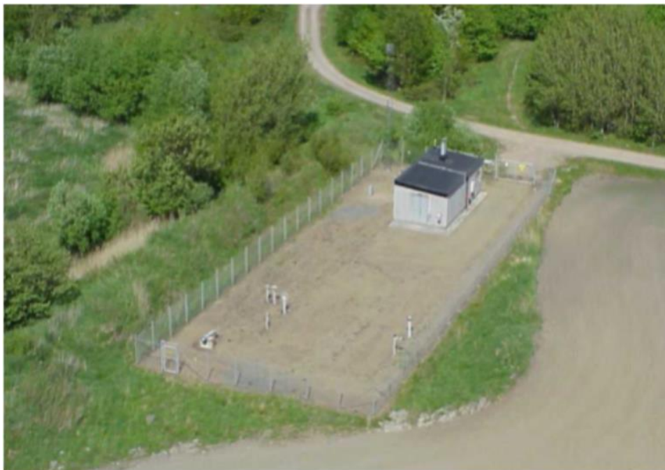
Figur 7. Exempel på mät- och reglerstation. Figuren visar det befintliga naturgassystemet. Justeringar kan förekomma i det slutliga skedet.
