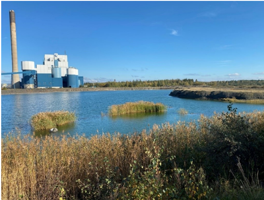
Kuva 7-2. Hankealueen itäreunan vesiallas ja täyttö. Taustalla näkyy Meri-Porin voimalaitos. Kuvan suunta kohti koillista. Kuvan 7-4 piste B.
