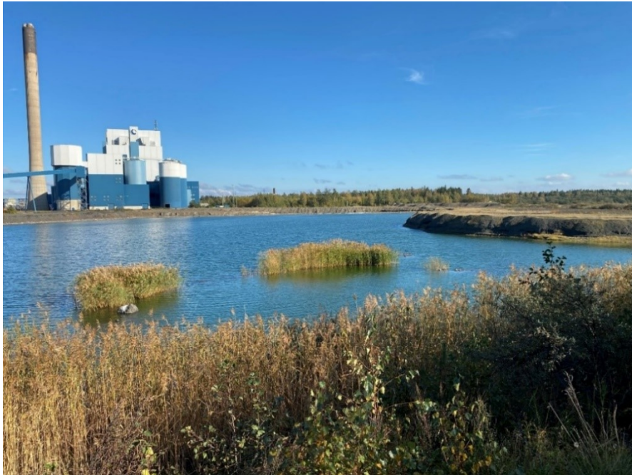
Kuva 6.2-2. Hankealueen itäreunan vesiallas ja täyttö. Taustalla näkyy Meri-Porin voimalaitos. Kuvan suunta kohti koillista. Kuvan 6.2–4 piste B.
