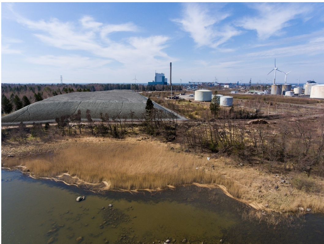
Kuva 6.11-11. Pohjoinen hankealue, kuonan varastointialue (kuonakasan maksimitilavuus) pohjoisesta kohti etelää katsottuna (havainnekuva, valokuva Einari Vuorinen).
