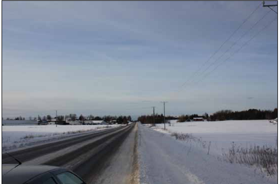
Figur 20. Kraftledningsalternativ A1 längs Strandvägen parallelt med den nuvarande kraftledningen. Bilden är tagen från Näsby, där den nuvarande kraftledningen korsar Strandvägen.
