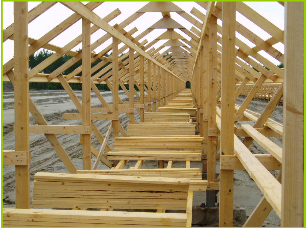
Kuva 4.8 F : Kattotuolikehät pystyssä , lattian teko edessä ( Alahärmä 2004)
