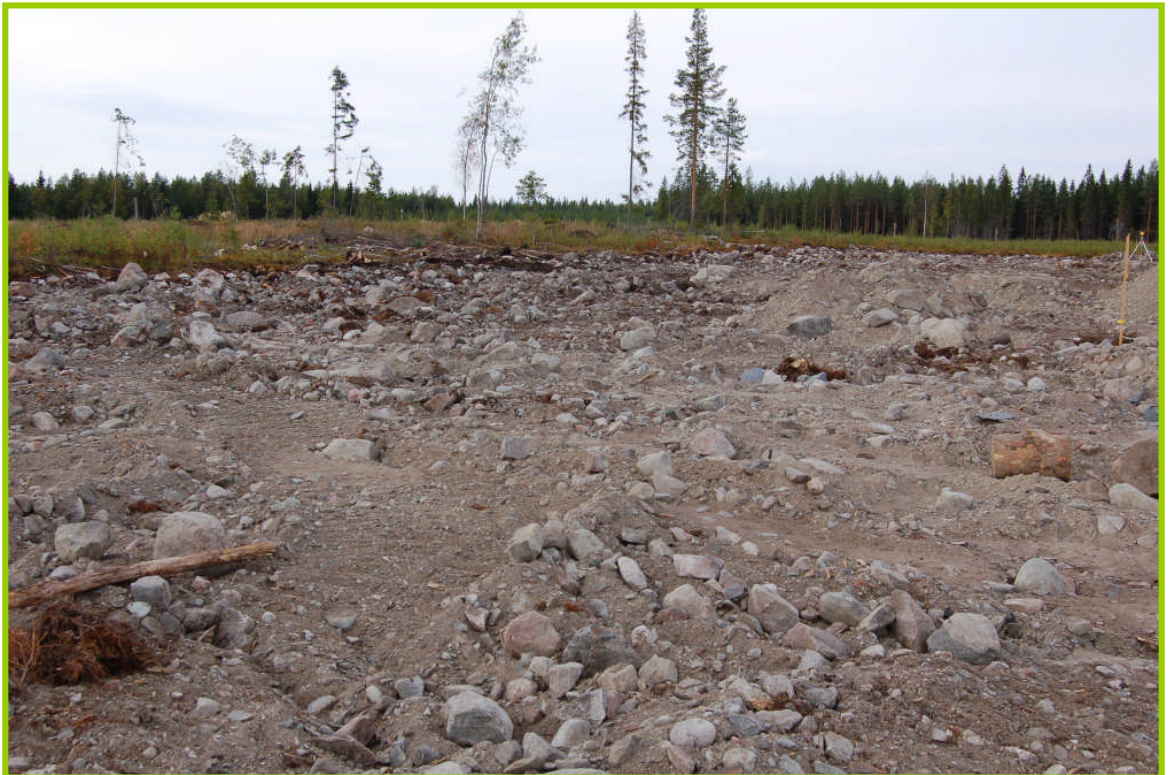
Kuva 4.8A : Tarha – alue pintamaiden poiston jälkeen ennen maansiirtoa ja tasausta ( Himanka 2006 )
