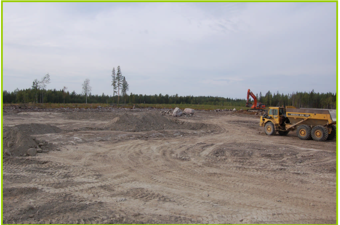
Kuva 4.8B : Maansiirto ja alueen tasaus käynnissä ( Himanka 2006 )
