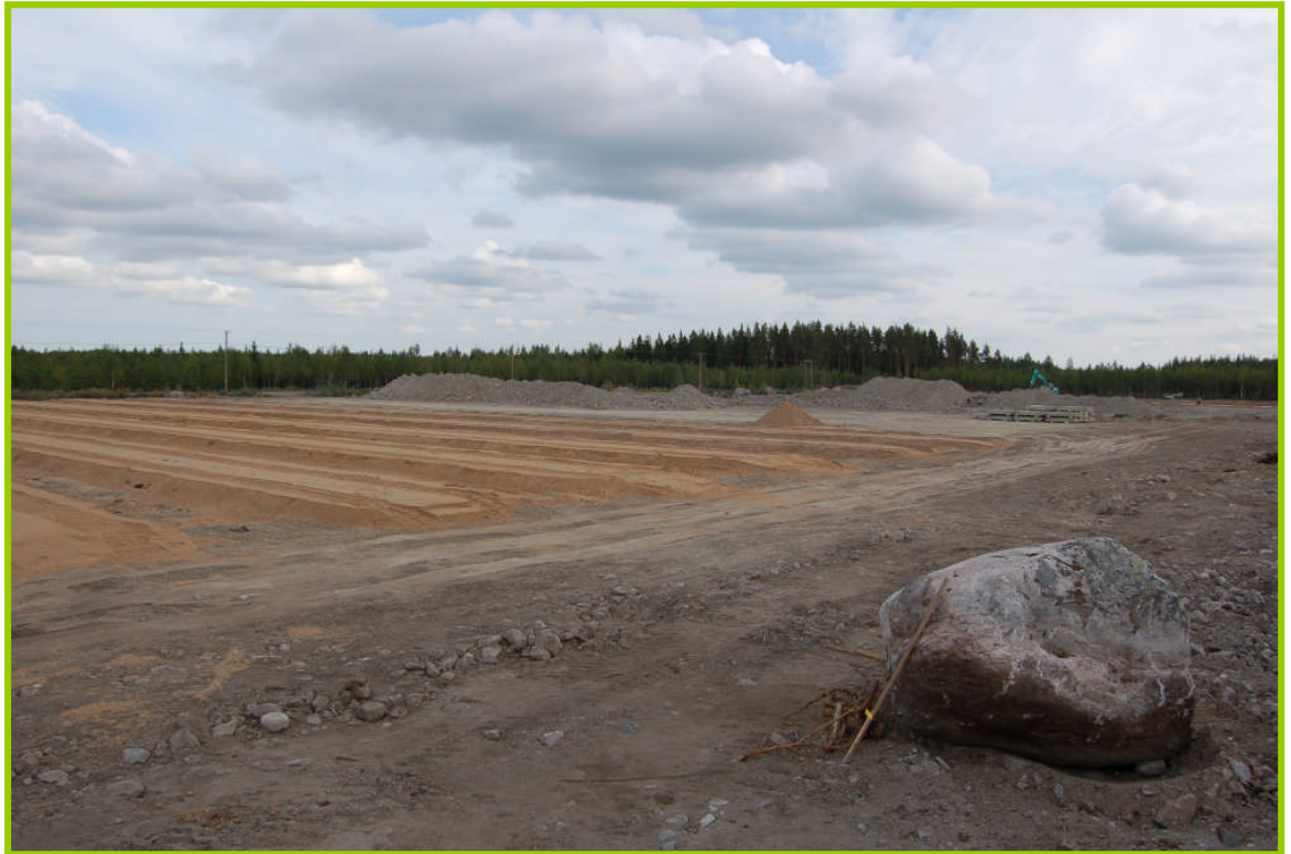
Kuva 4.8C : Varjotalojen ensimmäinen täyttö suoritettu ( Himanka 2006)
