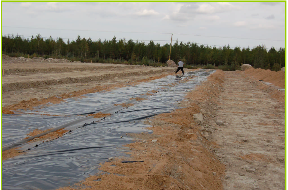
Kuva 4.8D: Tiiviskalvon laitto, keräysputki asennettu keskellä, suodatuskangaskaistan alla ( Himanka 2006 )
