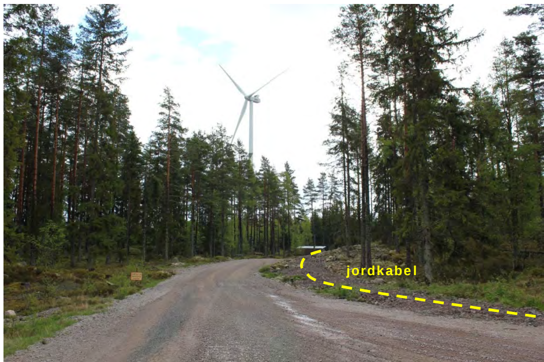
Figur 4-5. Exempel på bygg- och serviceväg för vindkraftparken. Vägarna används bland annat för transport av betong och grus samt kraftverkens komponenter. I driftskedet används vägarna bl.a. för årlig service. Diket för jordkabeln finns på vägens högra sida (foto: Jakob Kjellman / FCG).
