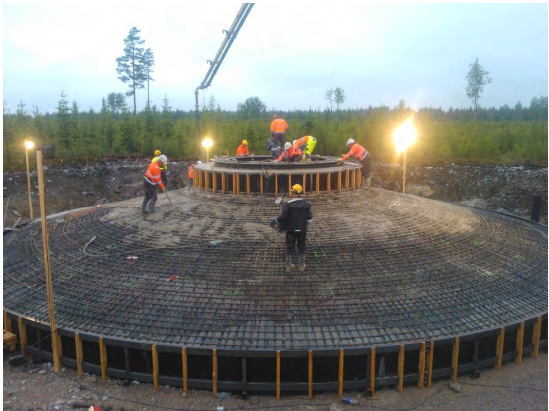
Figur 4-13. Gjutning av ett fundament (foto: Tuukka Lammi/FCG).
