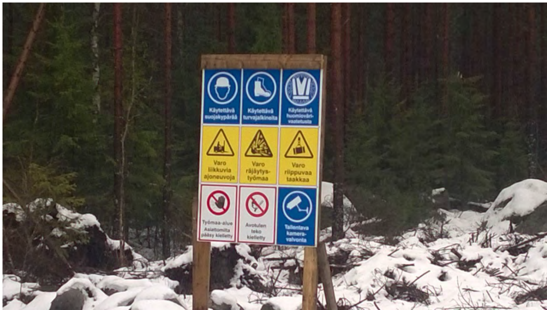
Figur 5-3. Exempel på säkerhetsföreskrifter under byggnadsskedet (foto Hans Vadbäck).
