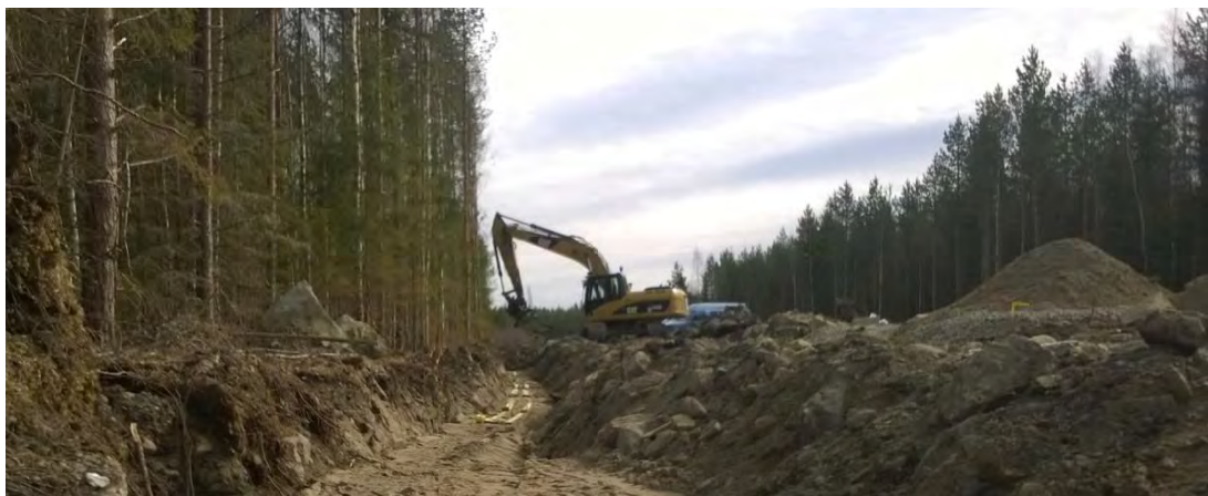
Figur 4-12. Installation av jordkablarna sker normalt intill servicevägarna (foto Janne Märsylä/FCG).
