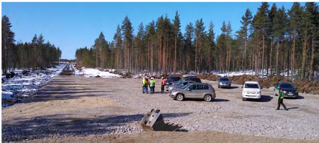
Figur 4-14. Monterings- och lyftområde för ett vindkraftverk (foto: Hans Vadbäck /FCG).
