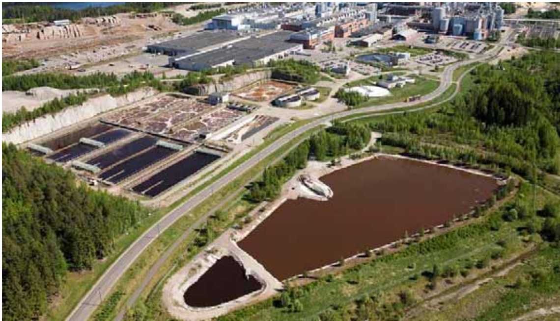
Kuva 11 Kymin jätevesilaitos. Etualalla 50 000 m 3 :n varoallas, taka-alalla aktiivilietelaitos.
