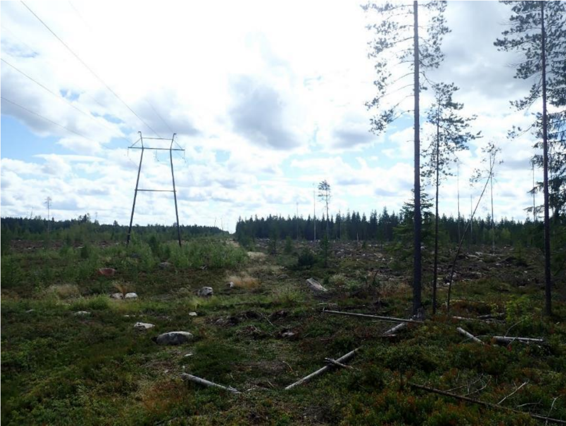
Kuva 5. Pohjoisempi sähkösiirtoreitti Vetelin kuntakeskuksen länsipuolella Klaavunkankaalla. Kaakkoon.
