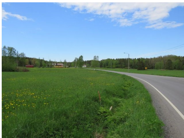
12. Kabelrutt längs Taklaxvägen, mot nordväst.
