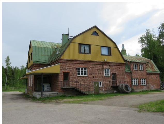
15. Före detta Taklax mejeri, mot sydost.
