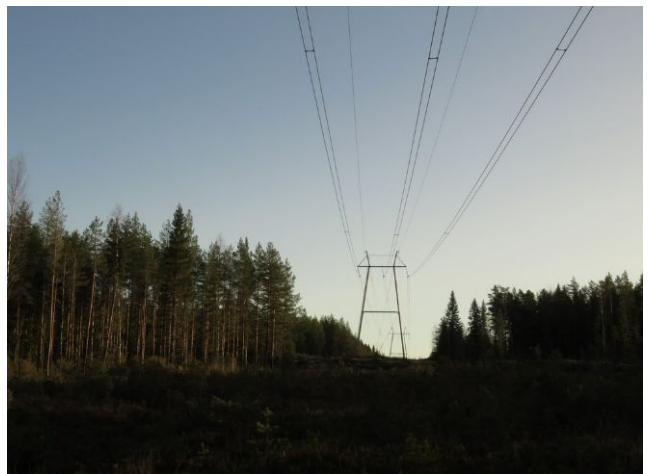
4. Kraftledningen mot öster i södra delen av utredningsområdet.
