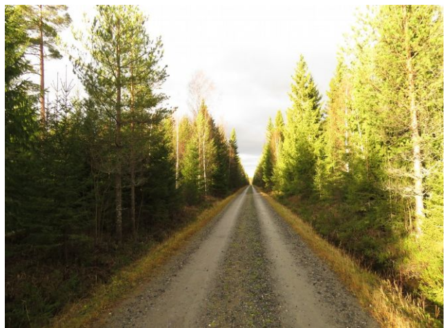
34. Elöverföring VE 3, jordkabel.
