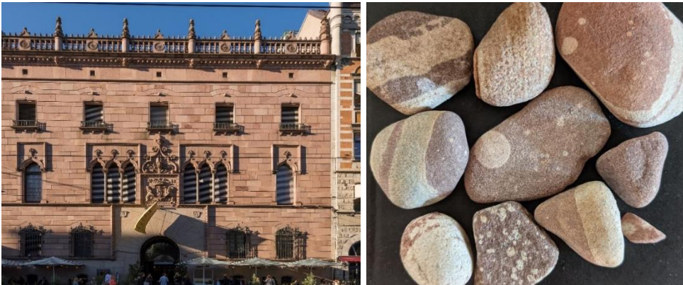
Figur 10. Gävlesandstenen är en hård bergart som sedan länge använts som byggnadssten, exempelvis Hallwylska palatset i Stockholm (foto Holger Ergaard). Jotnisk sandsten är ofta ljusgulröd och ibland mönstrad, fotot t.h. visar närbild på Roslagssandsten som hittats i kustnära delar av mellersta Östersjön (foto Kristoffer Pöljö).
