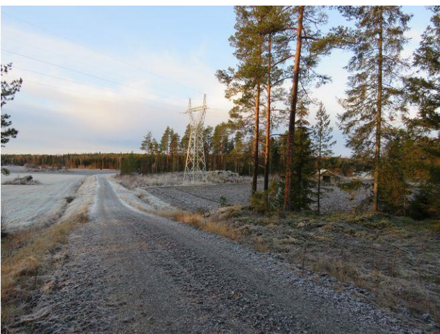
26. Ledningssträckning norr om Kärkinemossen.
