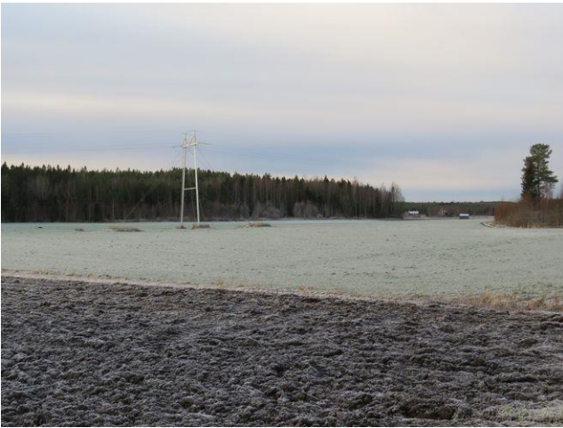
24. Ledningssträckning söder om Leukus.
