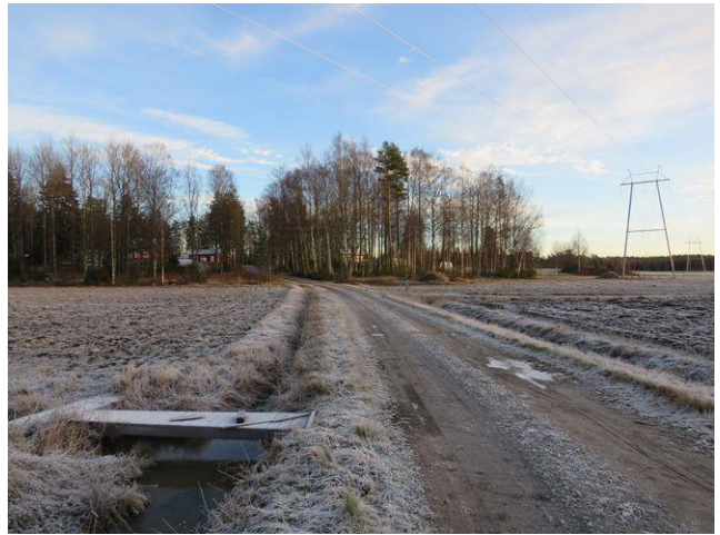
25. Ledningssträckning söder om Ohlsson, mot nordost.
